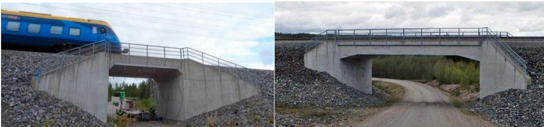
Figura 137 Ejemplos de realizaciones de puentes pórtico de hormigón para tráfico ferroviario. Fuente: izq. [67] y dcha [68].
