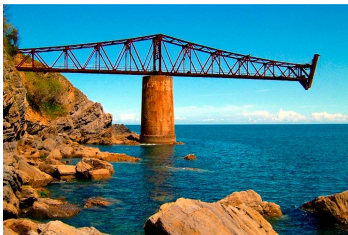
Figura 1.15. Cargadero minero de Dícido [13]
