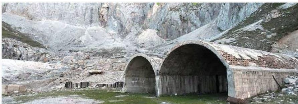
Figura 4.2. Minas de "Las Manforas" en su estado actual [38]
