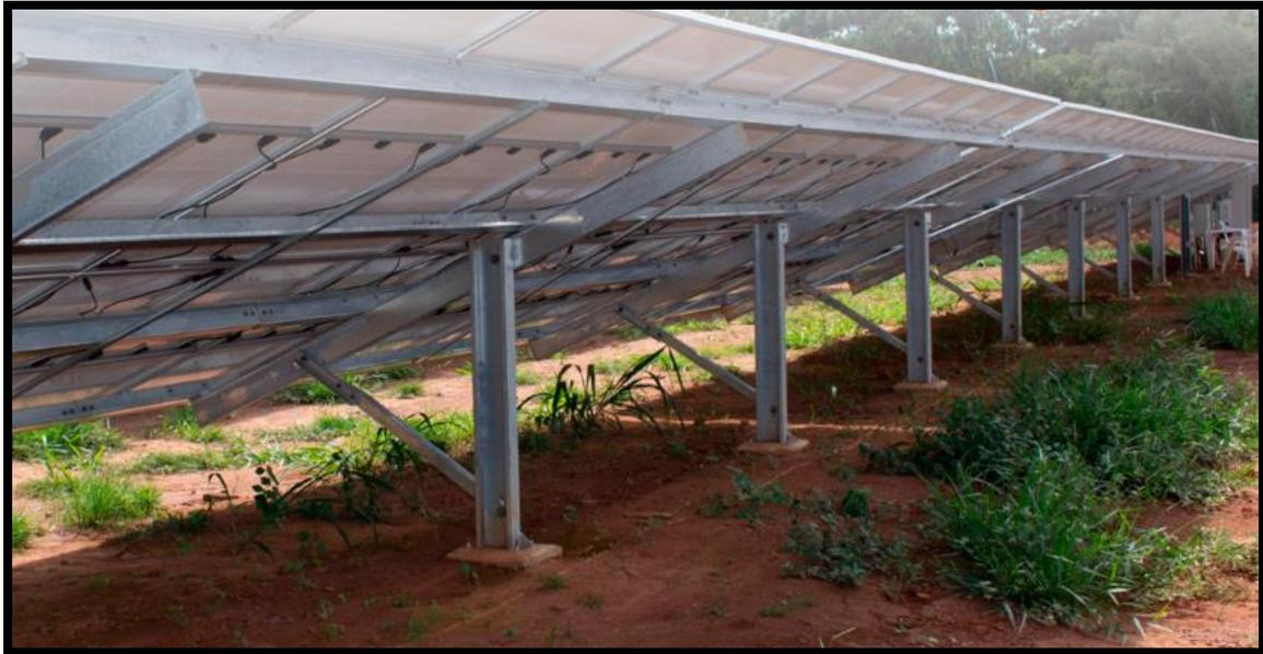
Ilustración 13 Forma estructura soporte módulos [Fuente fabricante Norland]
