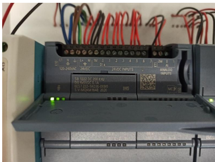
Figura 34. Módulo añadido de 4 salidas digitales.
