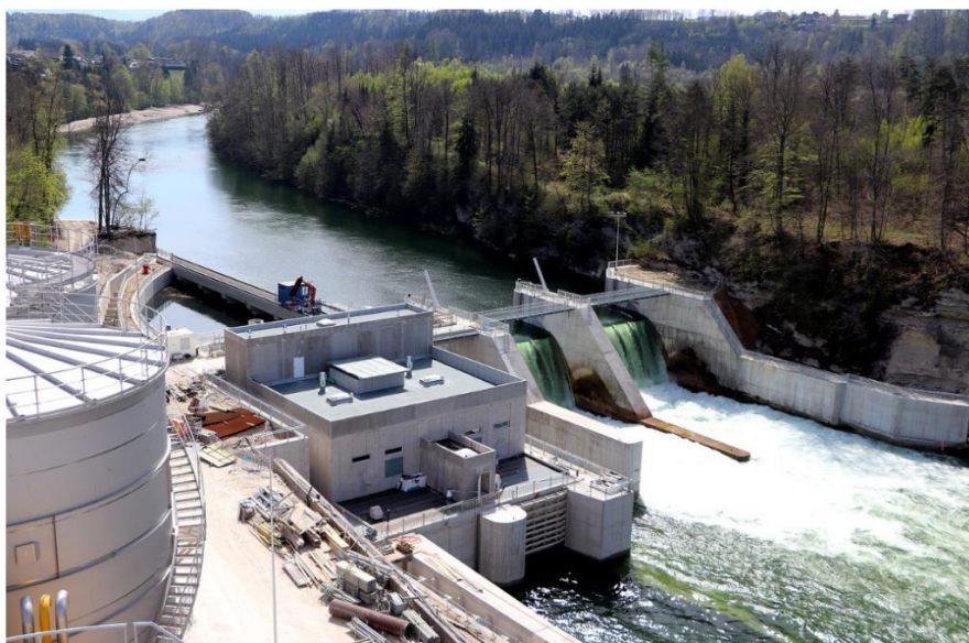
Figura 4.2: Central de agua fluyente. [14]
