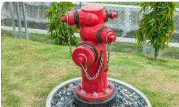
Ilustración 20 Hidrante exterior
