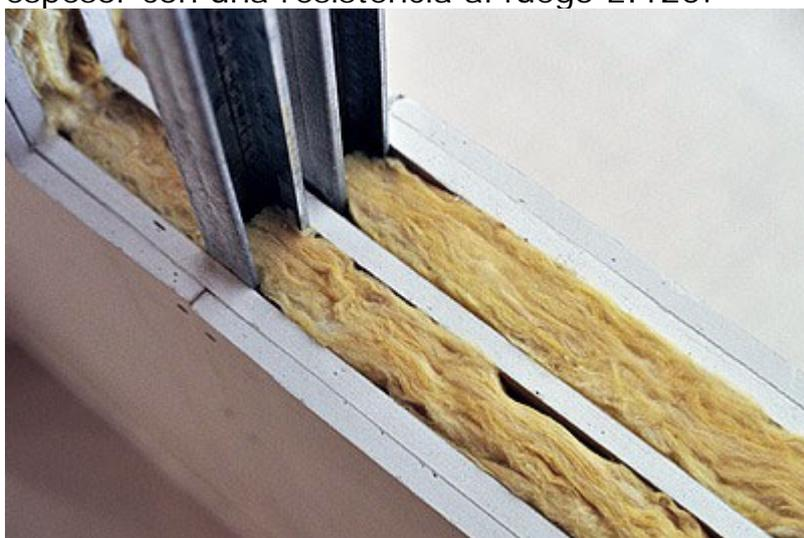
Ilustración 16 Pladur con lana de roca
