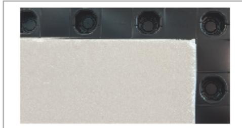
Después de haber colocado en las paredes de las habitaciones la banda perimetral K369A (con función aislante para eliminar el puente térmico en el borde y permitir las dilataciones mínimas del pavimento), se procede extendiendo y encastrando los paneles de manera que las filas siguientes se queden escalonadas.
