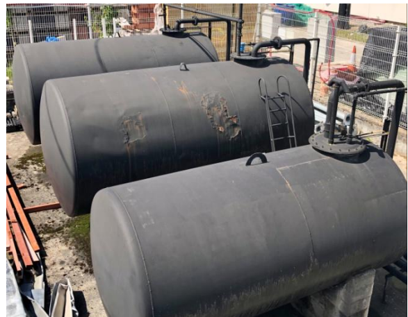
(I) Grupo electrógeno diesel Caterpillar (800 KVA). (II) Depósitos de Gasoil.
