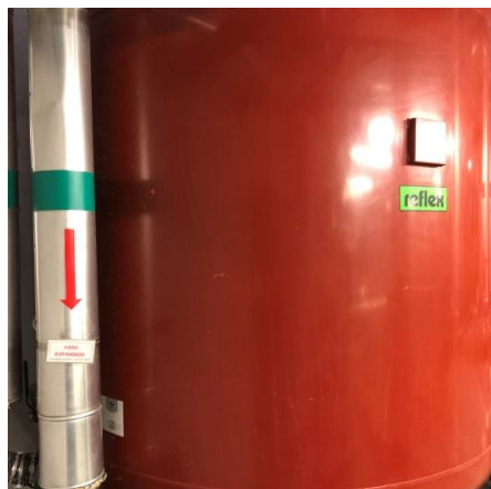
ILUSTRACIÓN 18 Vaso de expansión 3.000 litros
