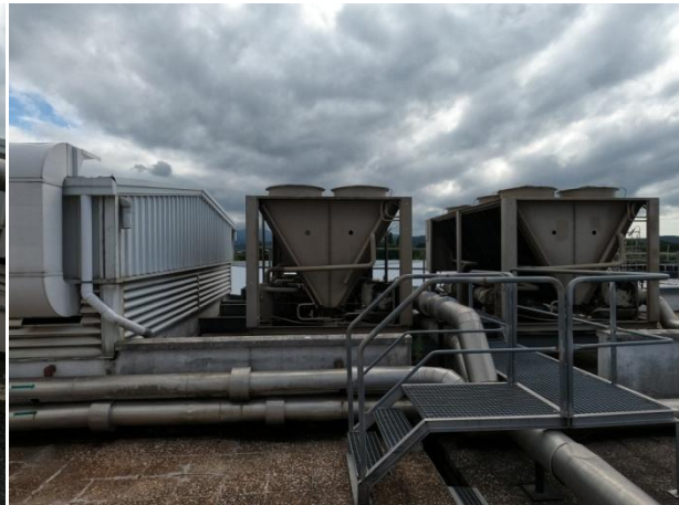
Instalaciones en cubierta. (I) Casetón cubierto de climatizadoras. (II) Enfriadoras Trane RTAD STD 115 en cubierta.
