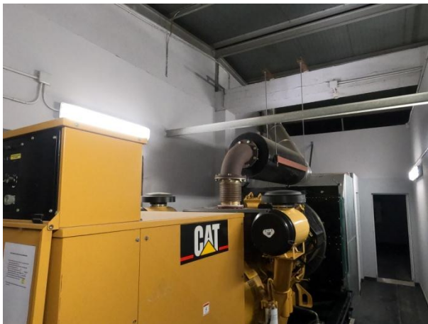
(I) Grupo electrógeno diesel Caterpillar (800 KVA). (II) Depósitos de Gasoil.
