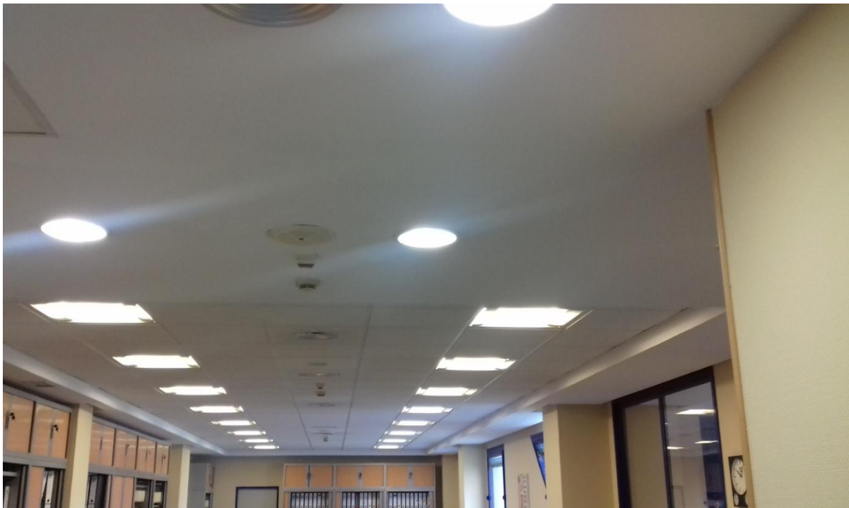
ILUSTRACIÓN 53 Situación actual de la iluminación en Área administrativa (oficina de administración)
