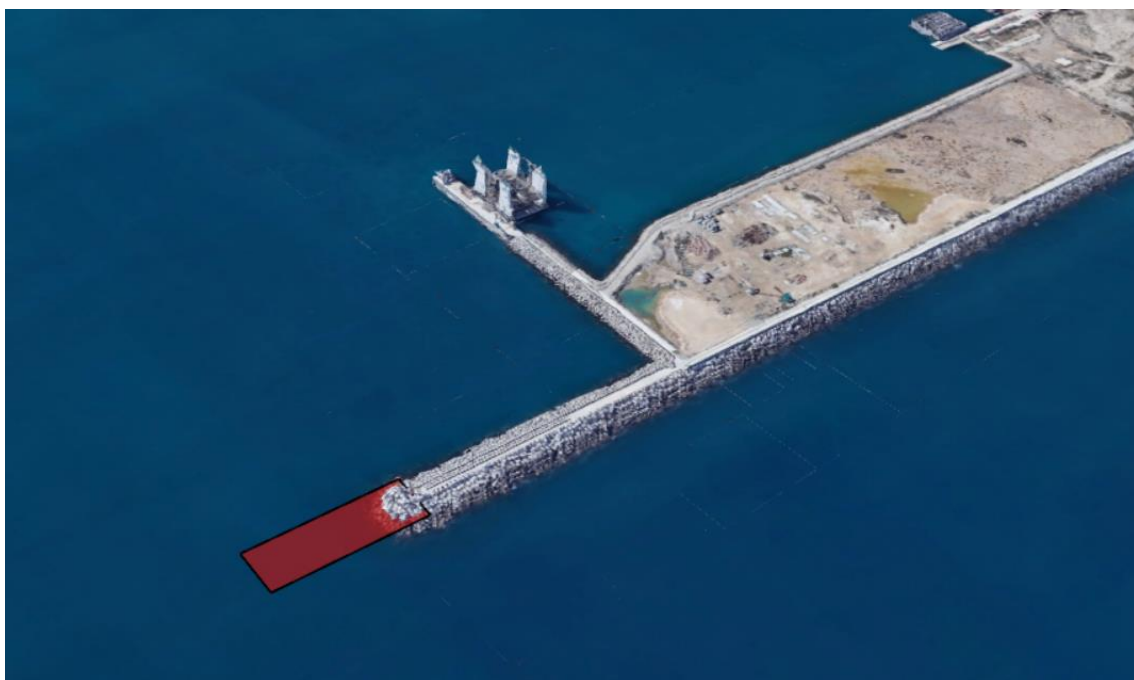
Figura 3. Imagen de satélite del Muelle de Poniente y zona de implantación (en rojo) superpuesta.
