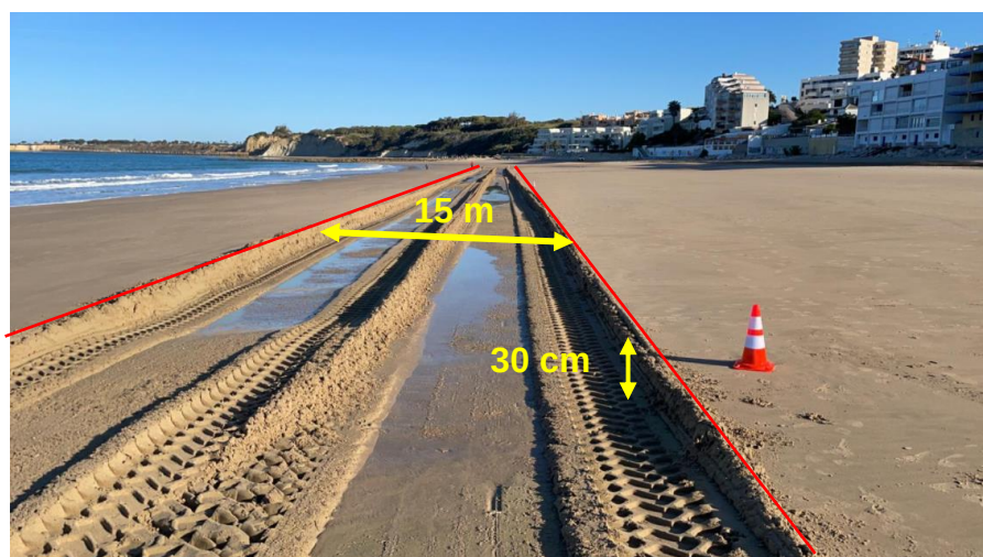
Figura 6. Zona de préstamo del scraping (entre las líneas rojas), consta de una zanja de 30 cm de profundidad y 15 m de ancho. Fotografía cortesía del proyecto BeachArt- IH.
