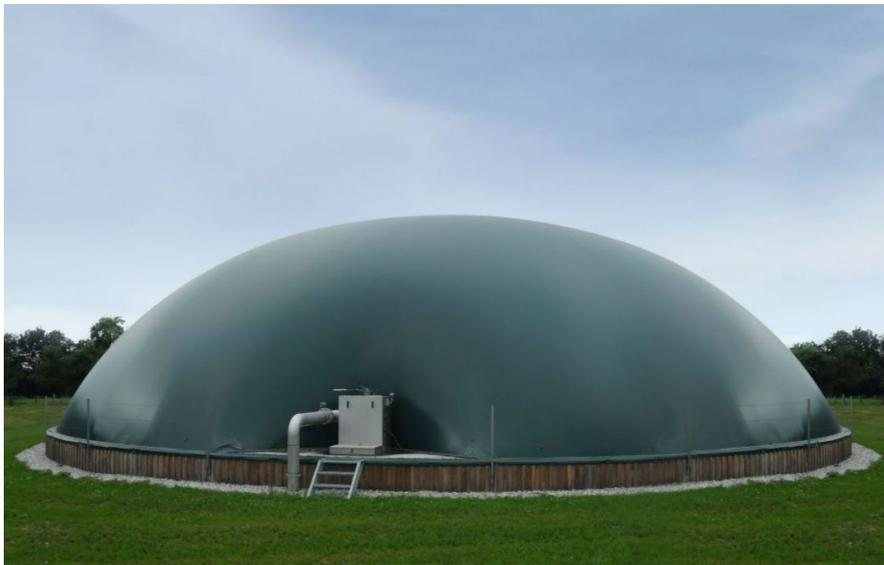
*Figura 6 - Gasómetro de doble membrana, cúpula en forma de 1/3 D*
