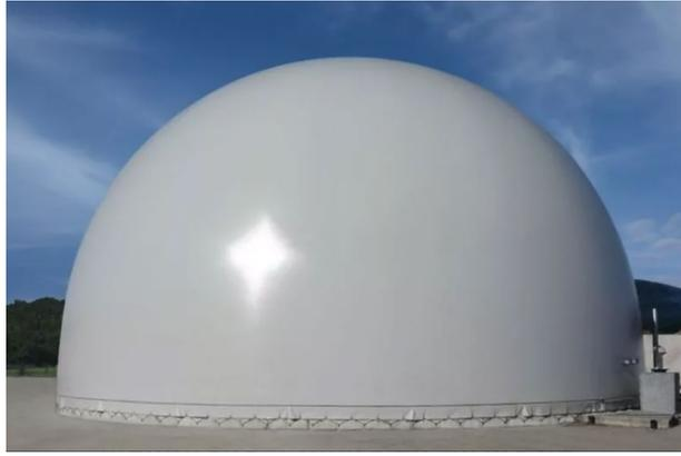
*Figura 13 - Gasómetro de doble membrana, cúpula en forma de  $\frac{1}{2} D$*
