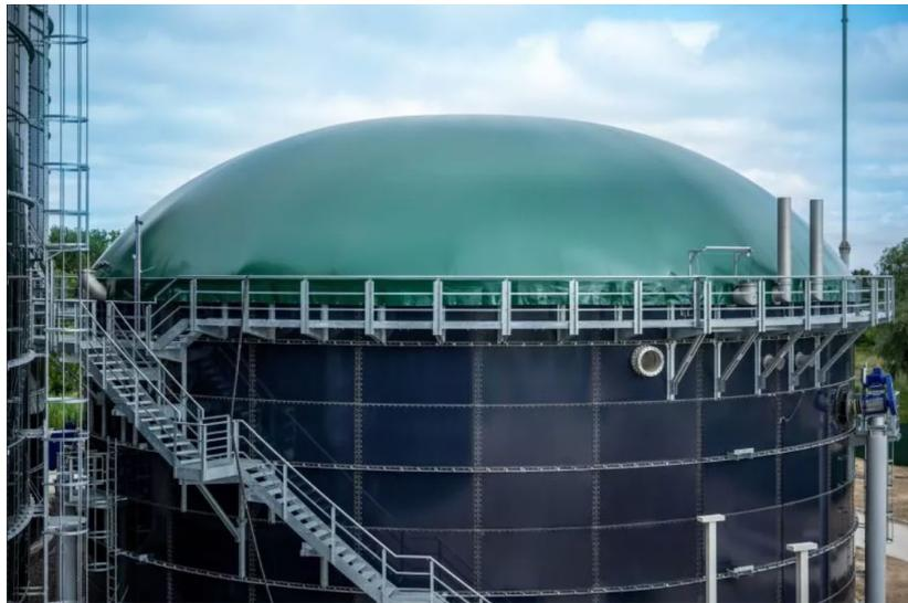
*Figura 11 – Biodigestor con gasómetro flexible de 1.779,00 m<sup>3</sup>*
