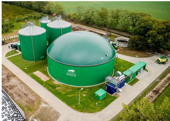
*Figura 5 - Gasómetro de doble membrana encima del biodigestor*
