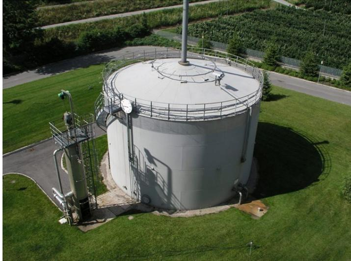
*Figura 3 - Digestor anaeróbico cilíndrico*
