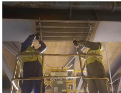
c) Fijación del refuerzo
