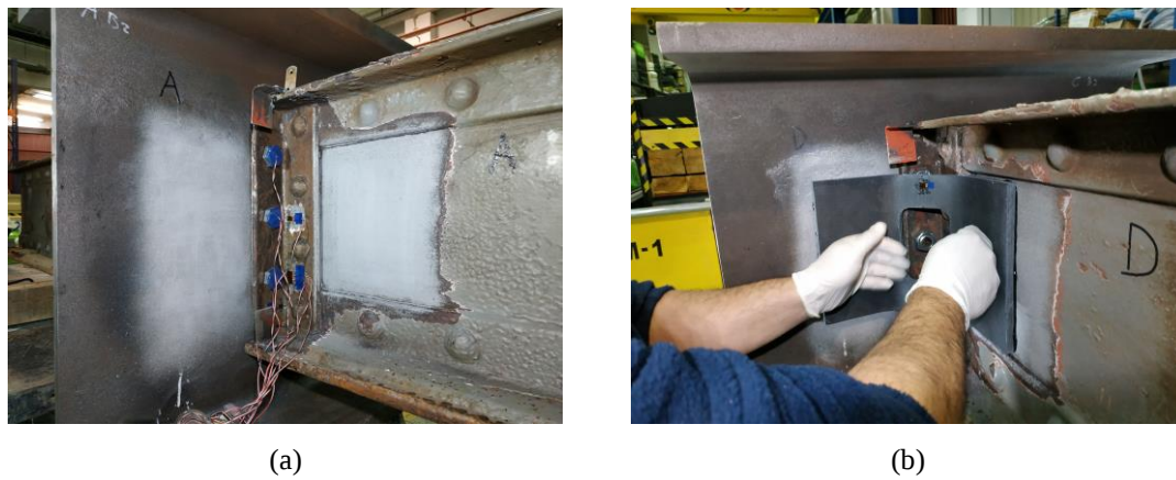
Figura 27. Instalación de los ángulos de PRFC para el refuerzo de la conexión larguero-vigueta. (a) Preparación de la superficie metálica. (b) Unión adhesiva del PRFC.
