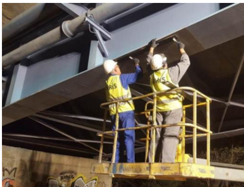
b) Aplicación del refuerzo
