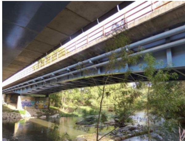
a) Vista del puente
