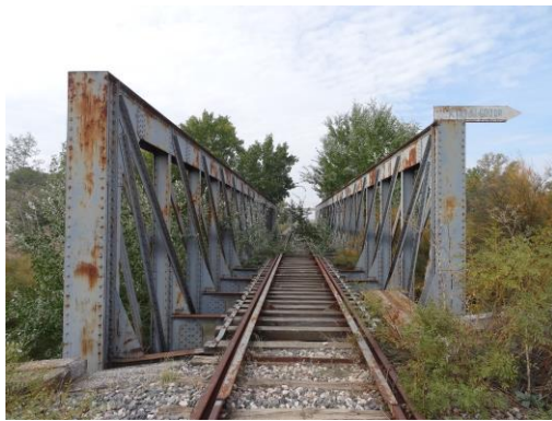
a) Vista del puente
