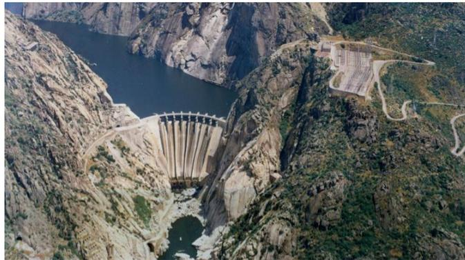
Ilustración 9. Central hidroeléctrica a pie de presa de Iberdrola
