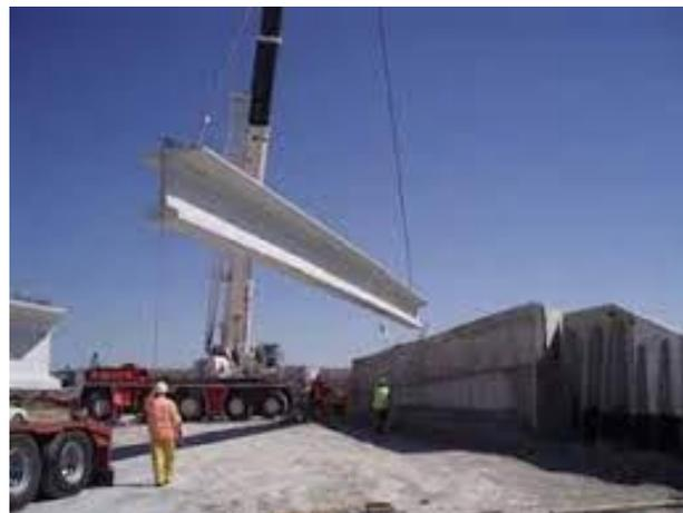
*Figura 27. Izado de una viga doble T con una grúa móvil.*
