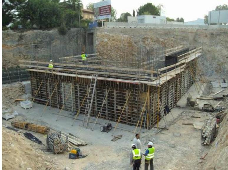
Figura 21. Colocación de ferralla y encofrado de la zapata de un estribo.
