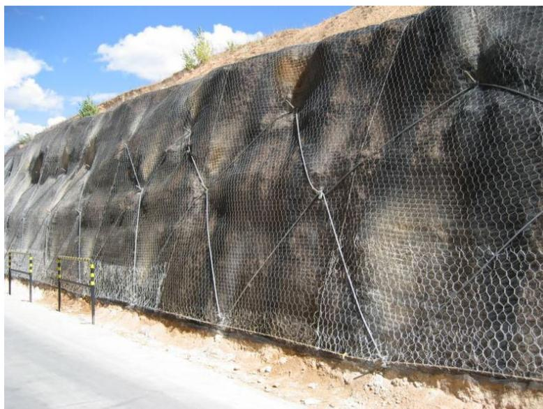
*Figura 4. Malla de triple torsión reforzada con bulones y cables de acero instalada en talud.*
