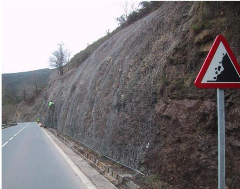
*Figura 3. Malla de triple torsión instalada en talud.*
