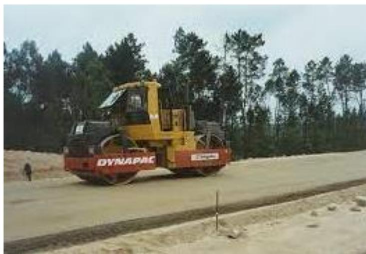
*Figura 15. Compactador de rodillos lisos compactando una tongada de zahorra.*
