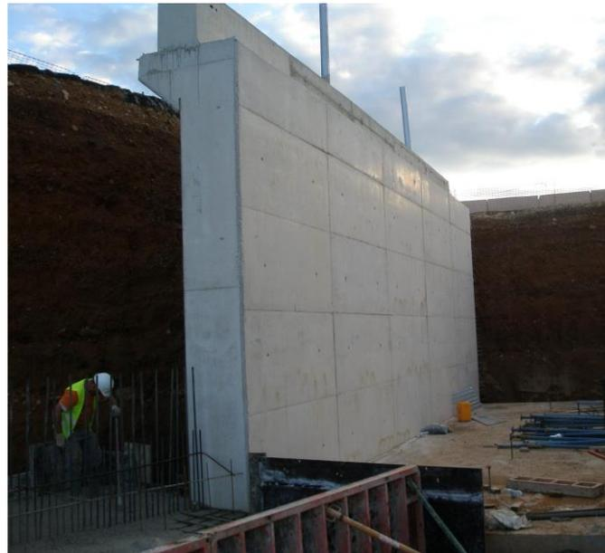
Figura 24. Fuste del estribo de un puente.
