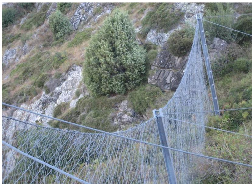
Figura 52. Pantalla dinámica instalada en talud.
