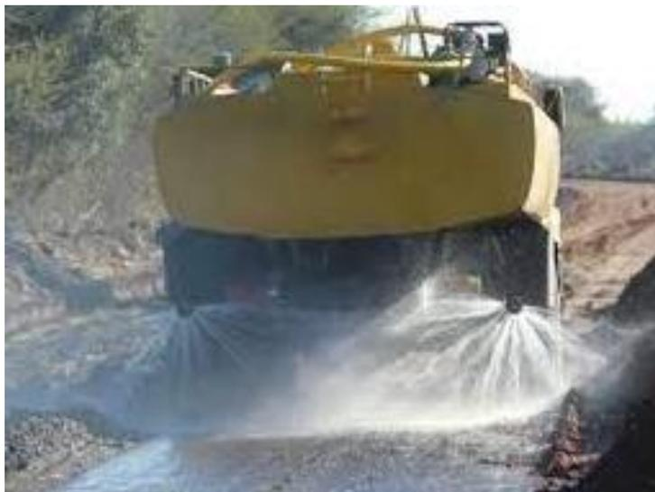
*Figura 14. Camión cisterna regando la tongada de zahorra extendida y nivelada antes de la compactación.*
