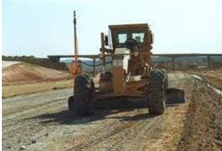
*Figura 13. Motoniveladora nivelando una tongada de zahorra.*
