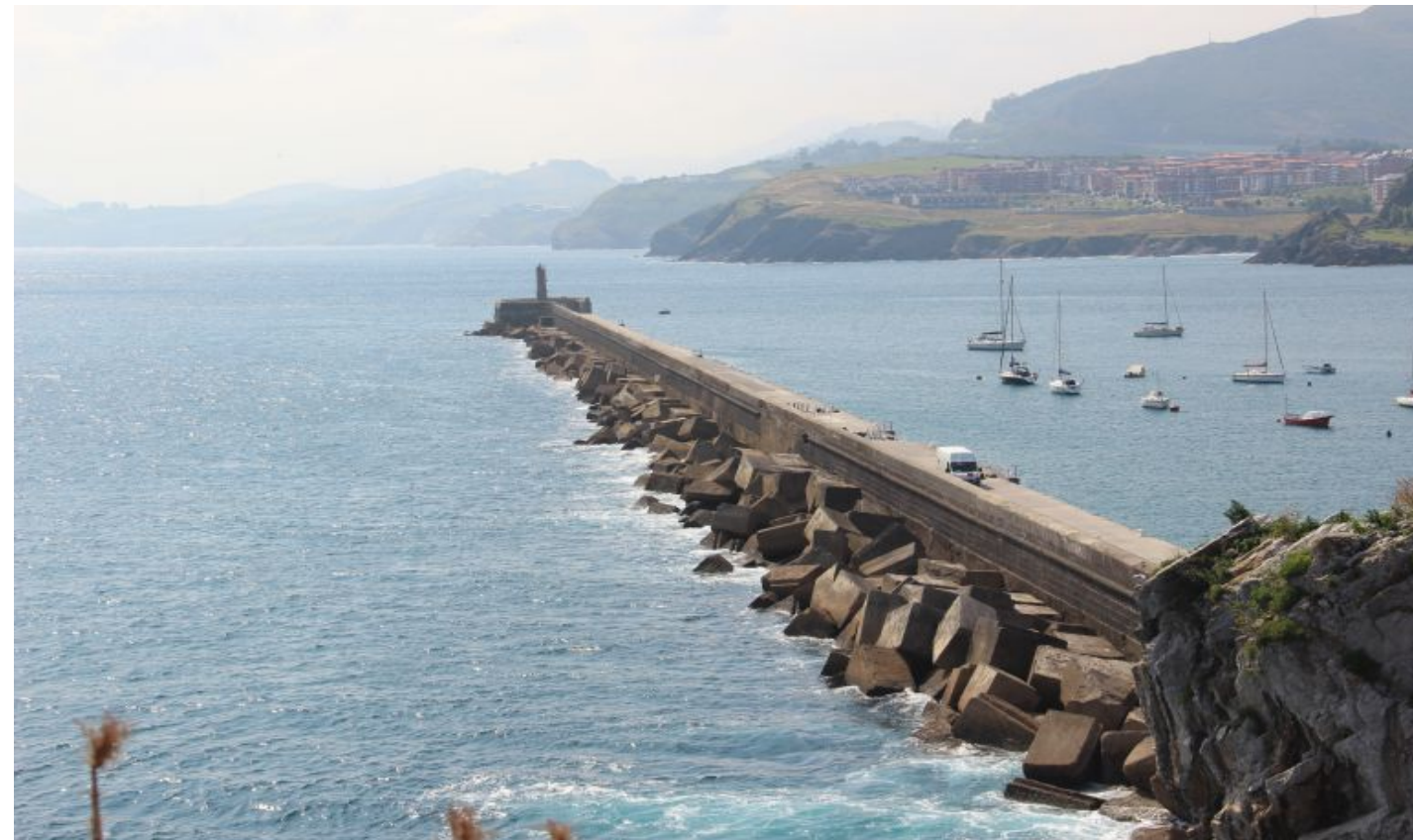
Figura 4. Dique norte de Castro Urdiales, cara externa con bloques de hormigón.
