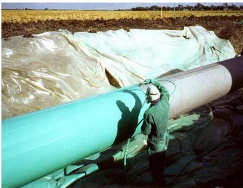
*Figura 50: Proceso de recubrimiento de tubería enterrada [80].*
