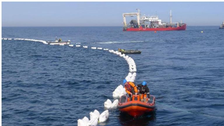
*Instalación de 24.5 km de cable submarino para el Parque de Anholt en Dinamarca
