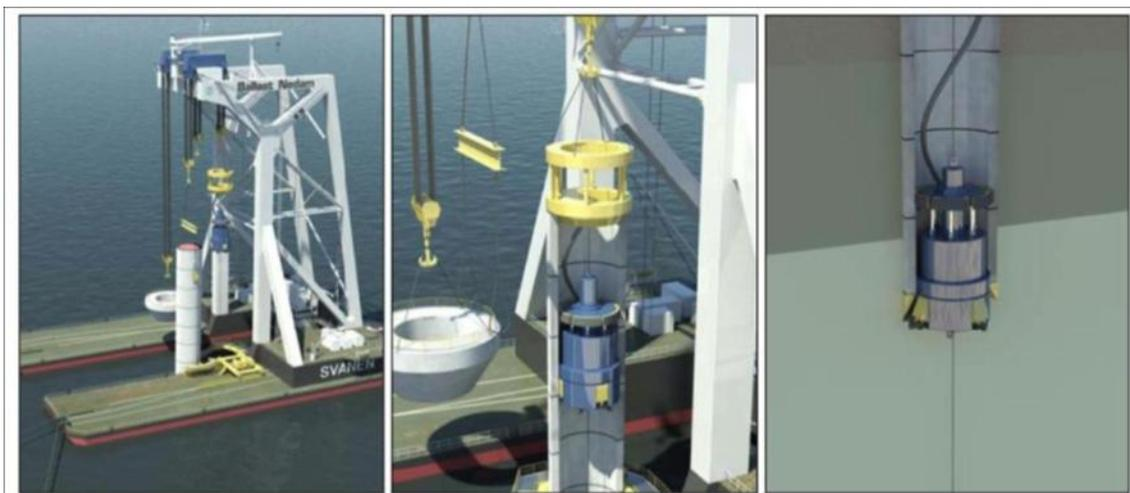
*Proceso de perforación de monopilote de hormigón*
