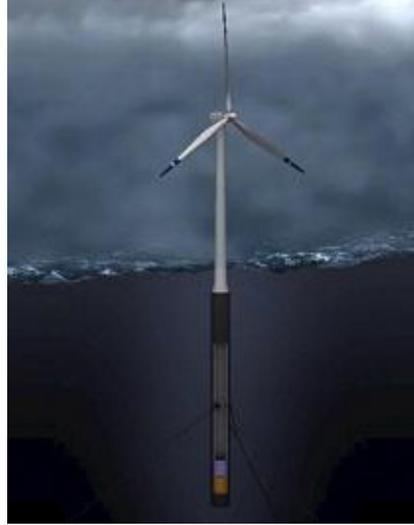
el sur de Noruega en Septiembre de 2009. La empresa Statoil ha invertido 53,4 M€. La unidad pesa 5.300 T y está compuesta por una estructura flotante mediante un depósito de acero (Spar) de 100 m de longitud sumergido
