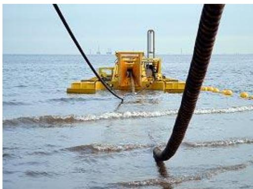
Instalación del cable submarino ([www.npower-renewables.com](http://www.npower-renewables.com))
