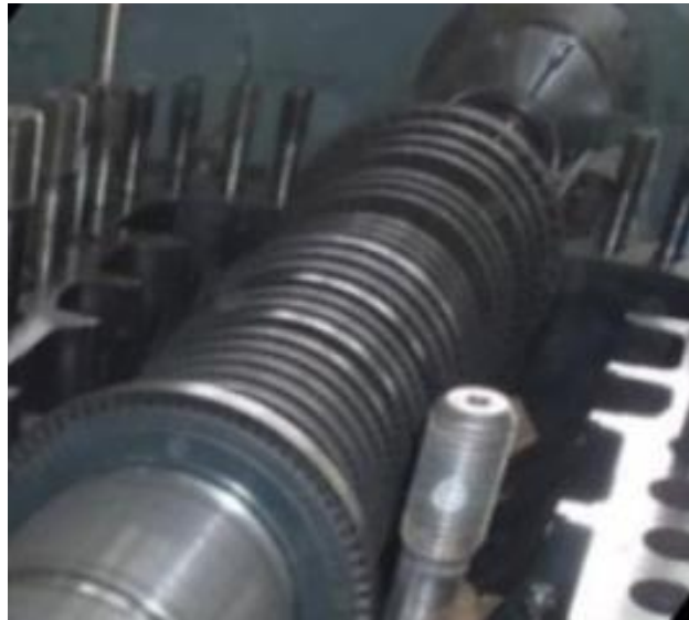
Figura 14 – Rotor de la Turbina de Vapor TASP
