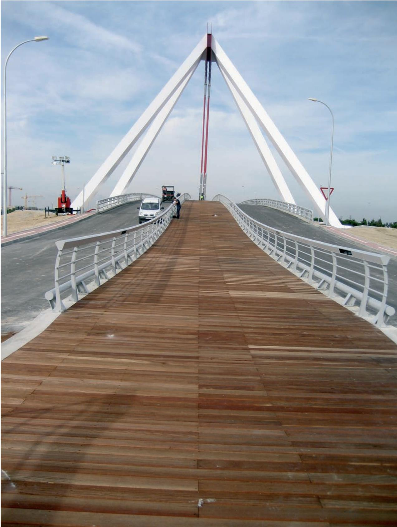
Foto 5. Vista de la acera central con pavimento de madera desde el lado Norte de la Autopista A6.
