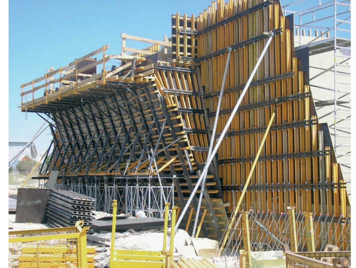
Foto 9. Encofrado frontal del Estribo E1.
