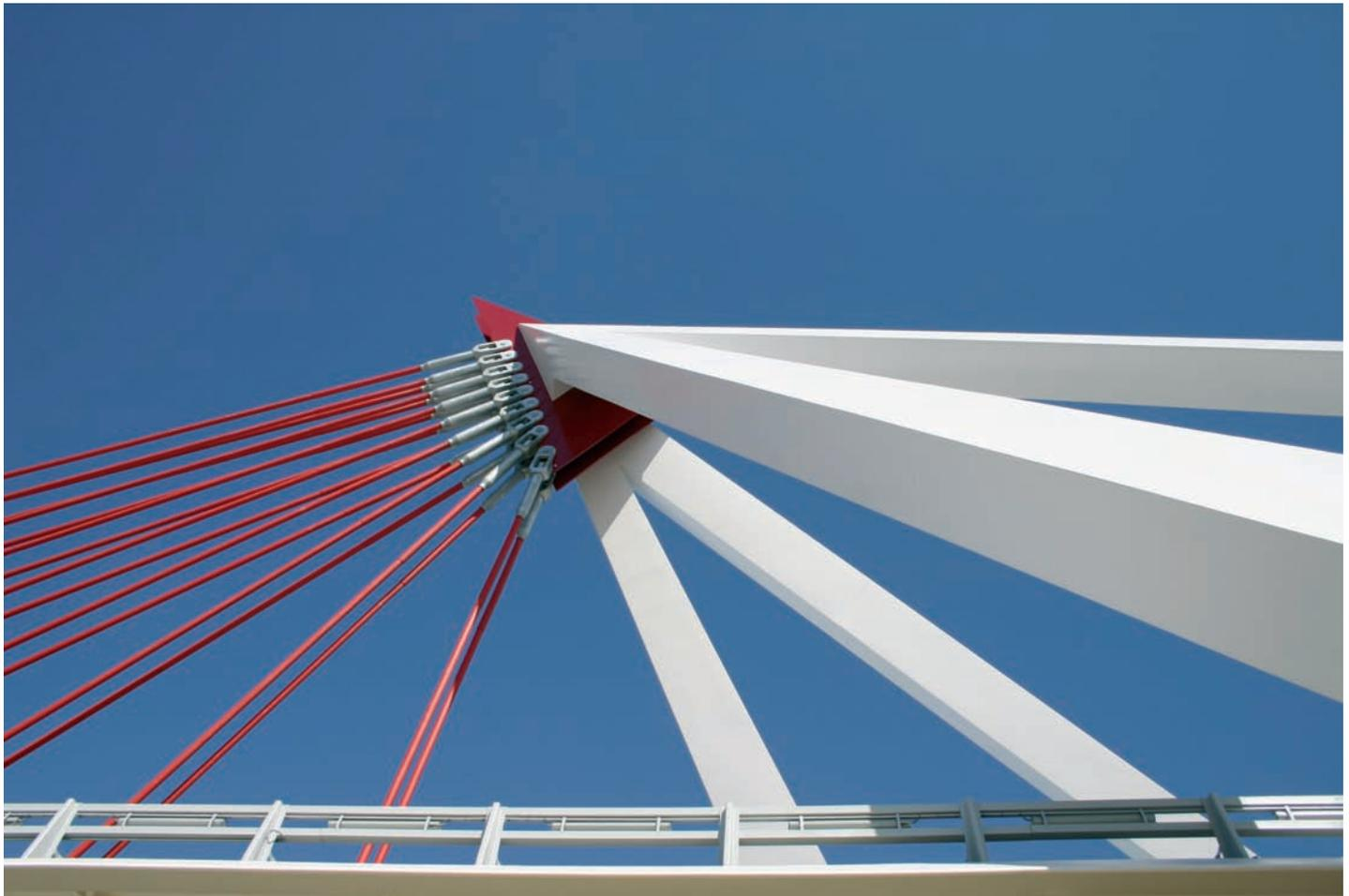
Foto 4. Vista inferior del conjunto de mástil y atirantamiento frontal.
