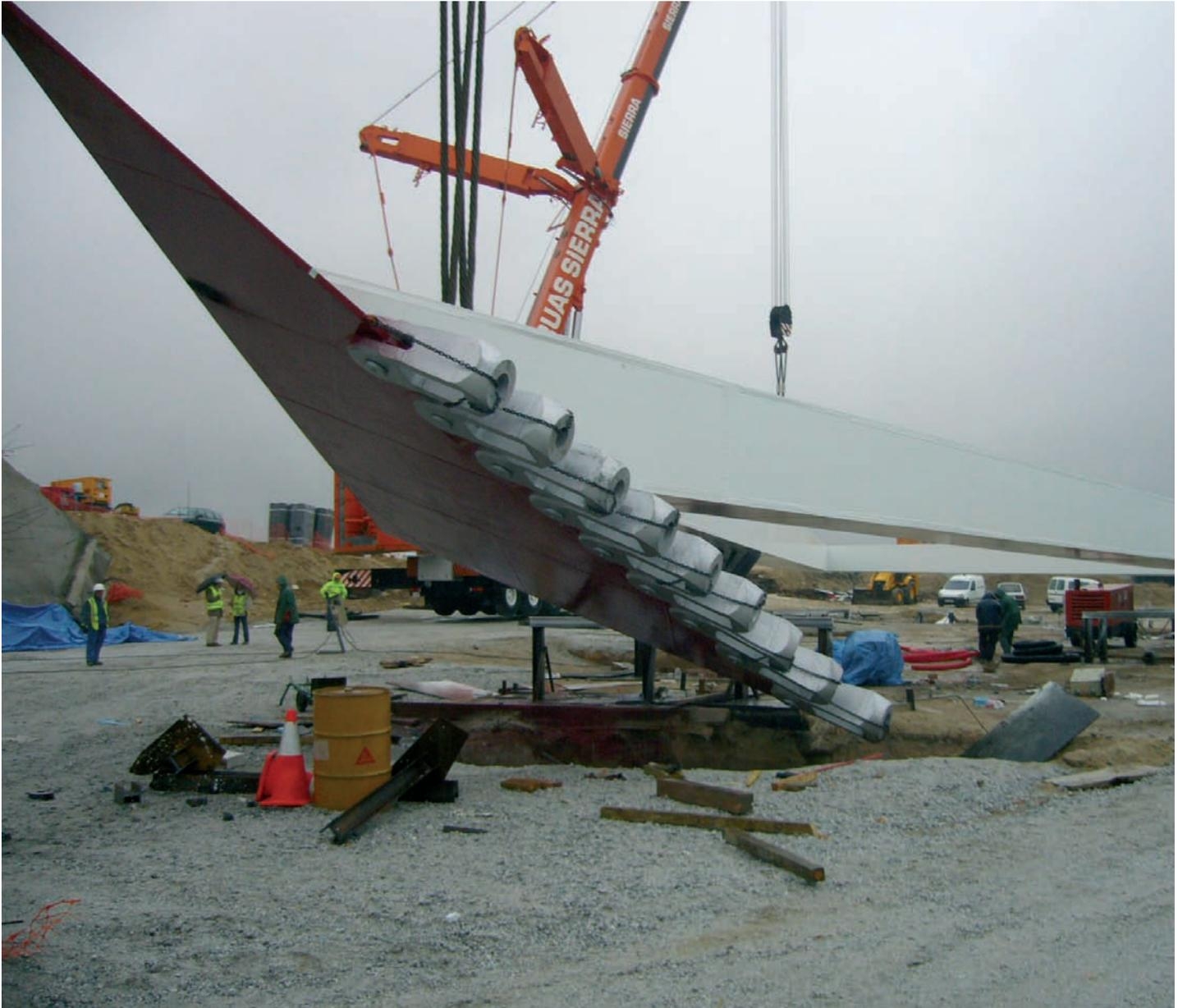
Foto 14. Izado de una de las dos piezas del mástil desde posición horizontal.
