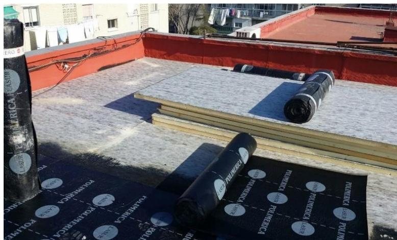
**Figura 21.** Proceso de impermeabilización de una cubierta (Fuente: Impermeabilizaciones Jigón)
