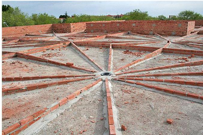
**Figura 22.** Ejecución de capa de formación de pendientes (Fuente: obrasonline.com, 2020)
