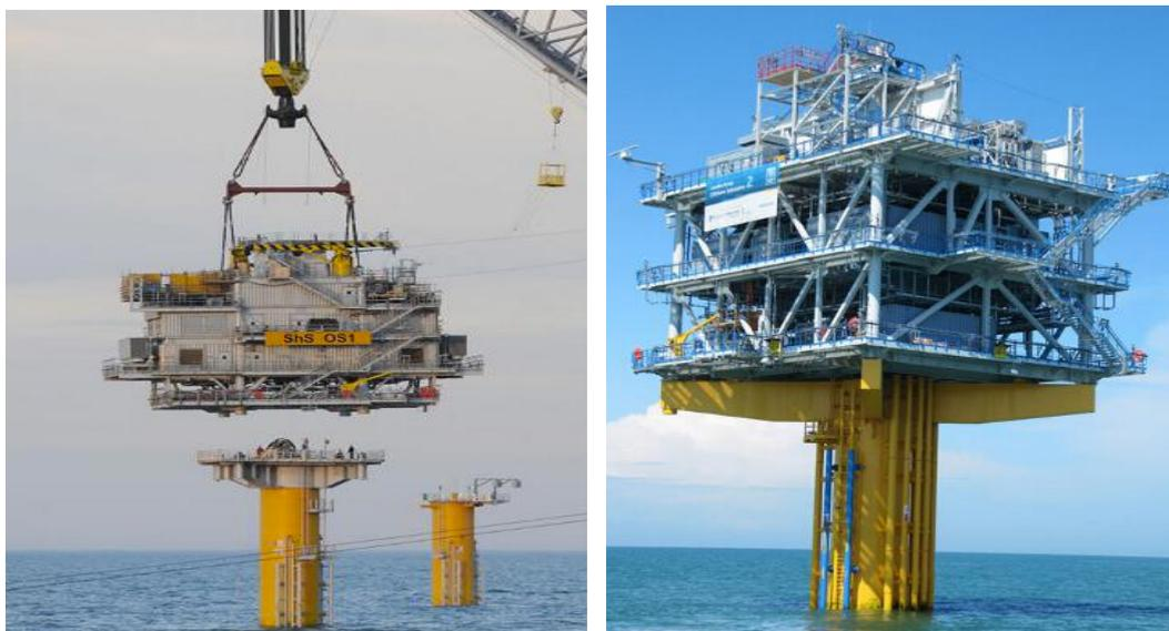
**Figura 47 Izado e instalación de la subestación 1 del parque London Array [48]**
