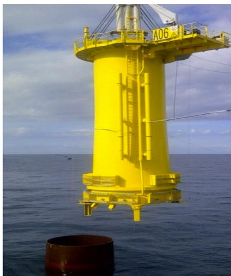
Figura 59 Pieza de transición para cimentación tipo monopilote [14]
