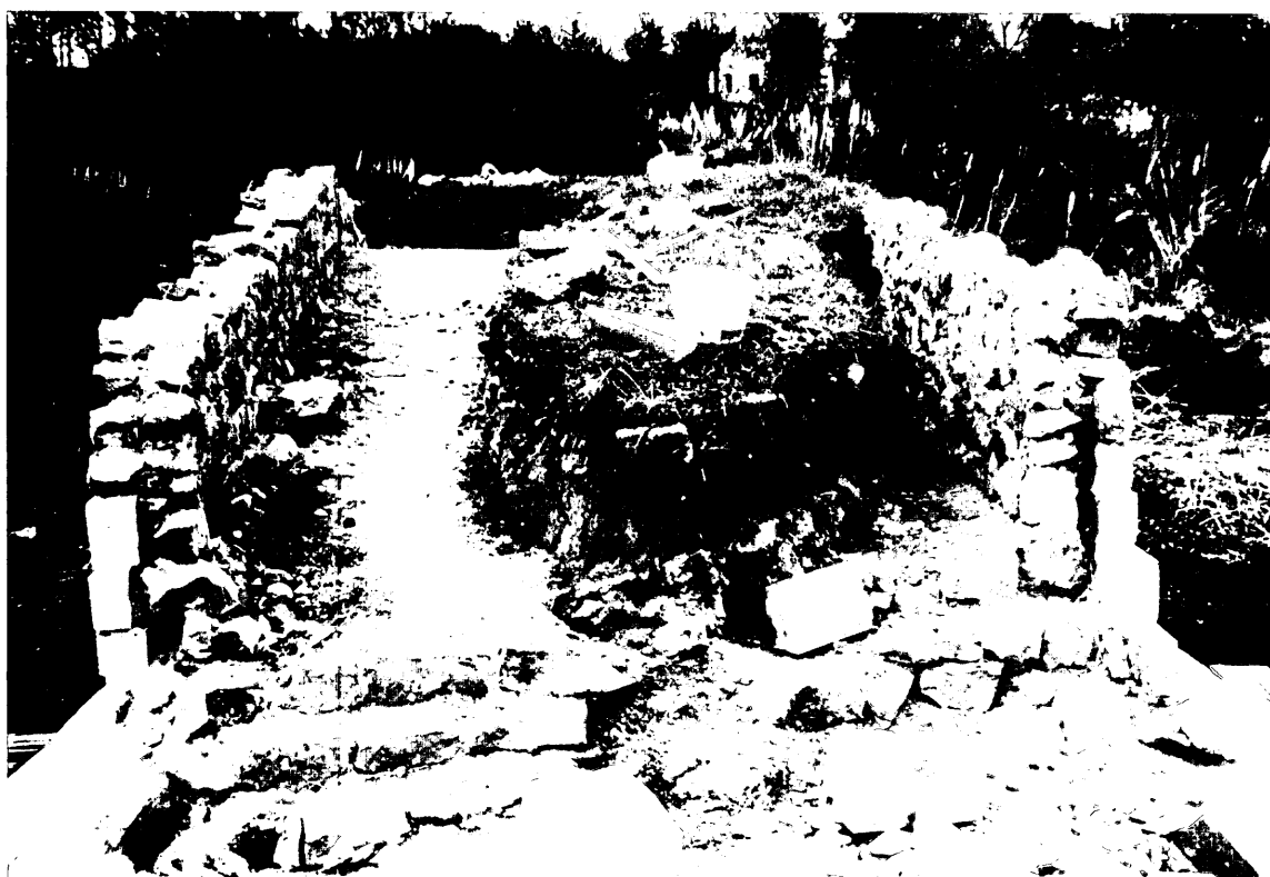
Figura 16. Acondicionamiento del extradós de la bóveda
