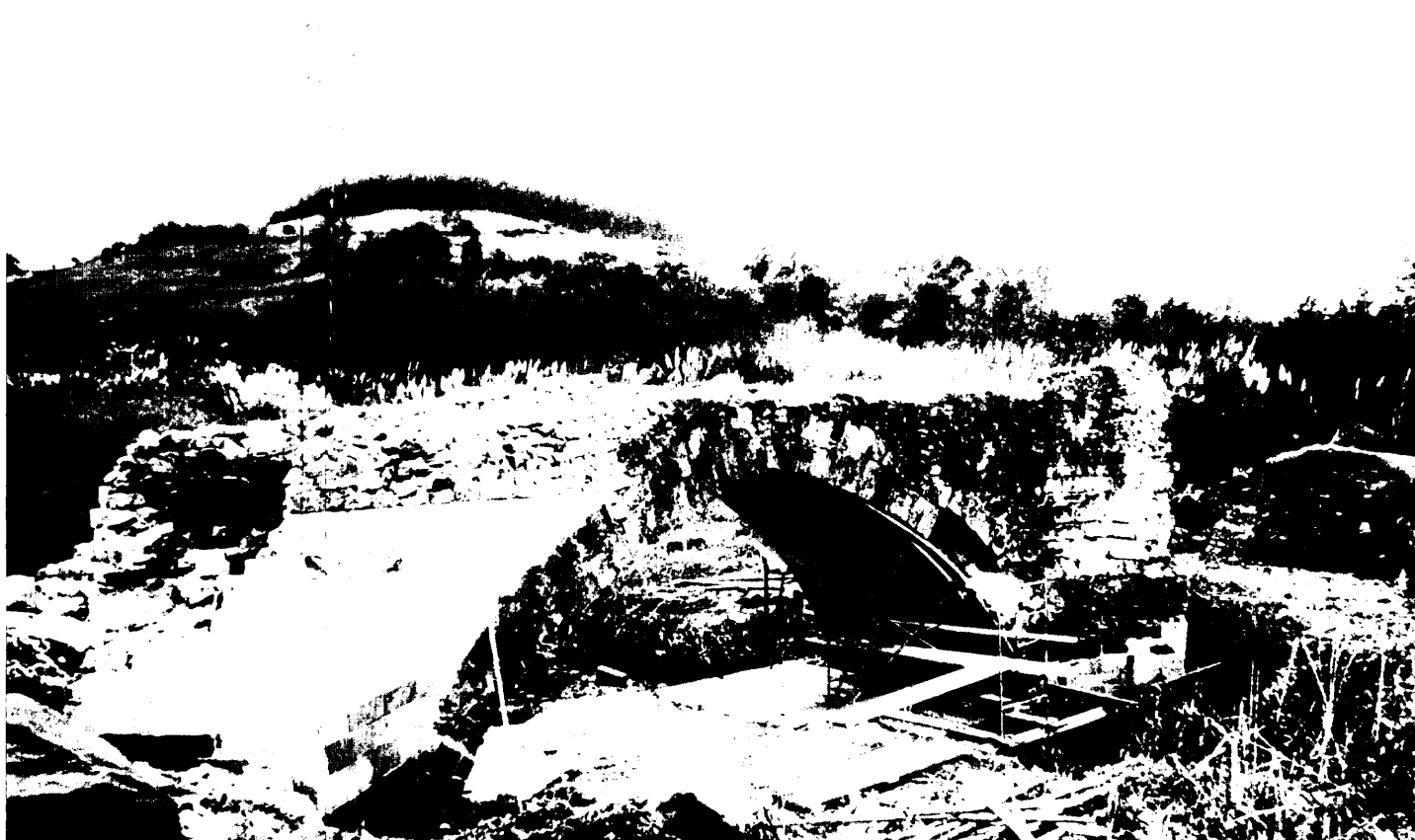
Figura 15. Vista aguas abajo
