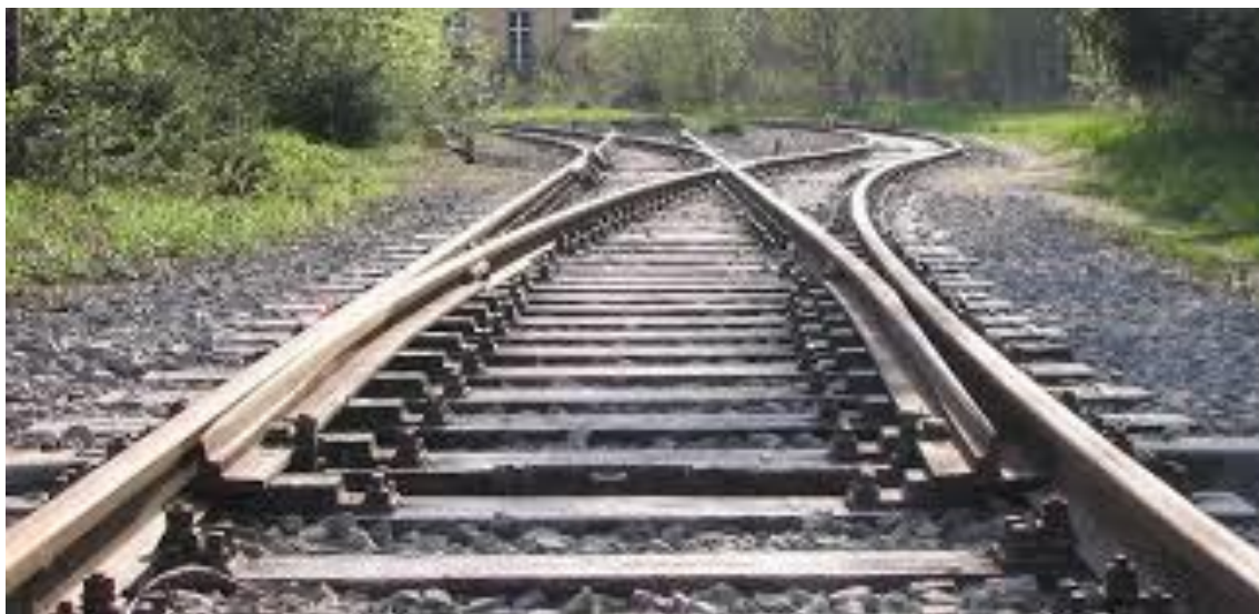
Figura 5.2. Ejemplo de aparato de dilatación de vía (bretelle).
