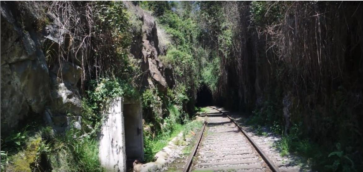
Figura A46: Entrada norte túnel San Pedro, se aprecian rocas y ancho para un solo carril. [52]
