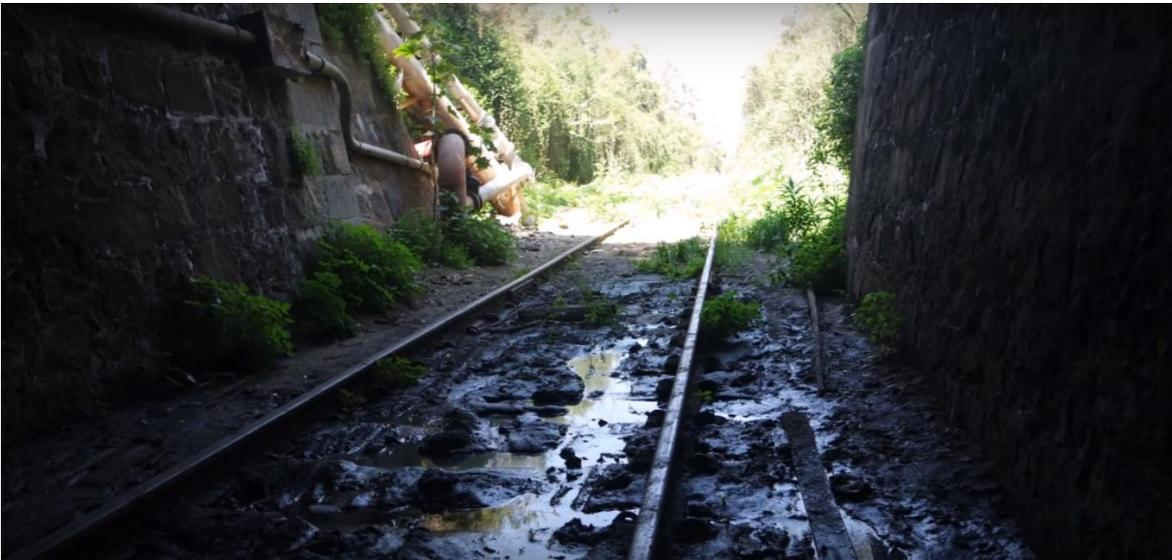
Figura A50: La estructura vial del interior del túnel presenta mucho desgaste, humedad y oxidación. [52]
