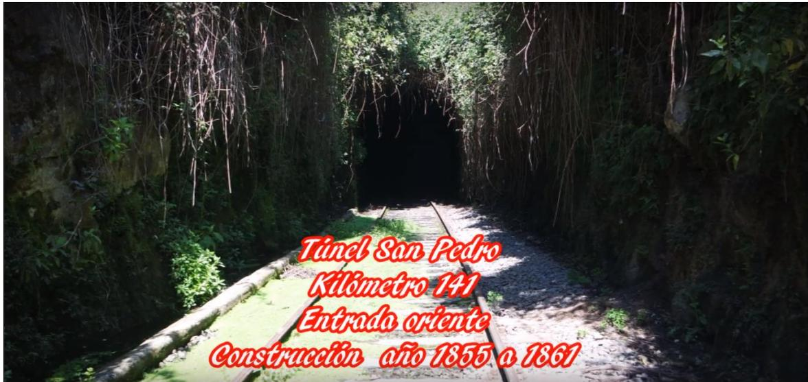
Figura A47: Entrada norte túnel San Pedro kilómetro 141, por el costado izquierdo se aprecia una conducción de aguas. [52]
