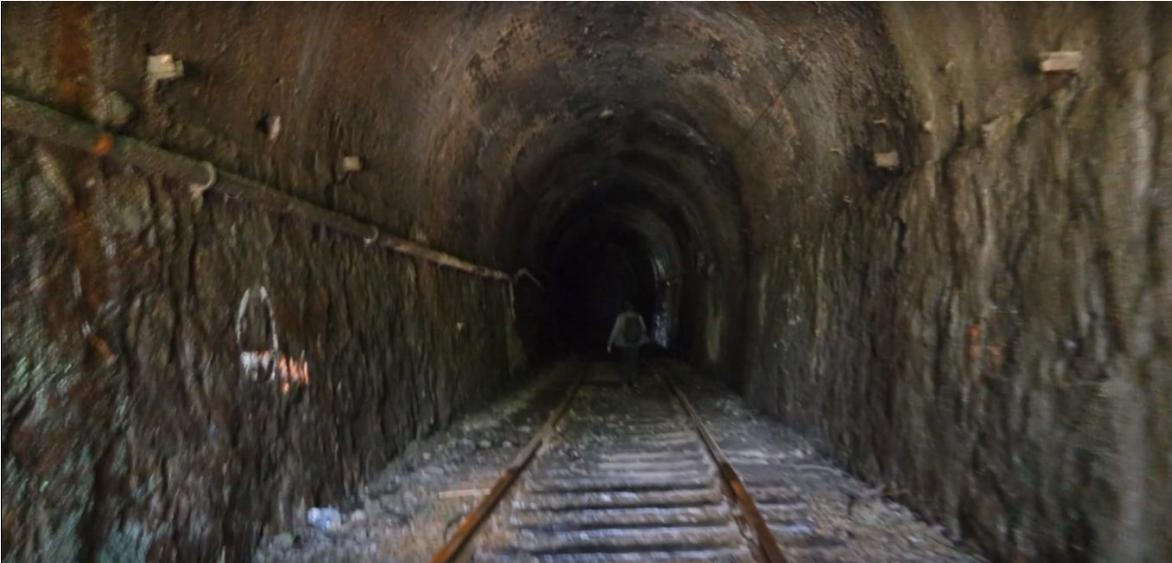
Figura A49: Vista interior del túnel, paredes deterioradas y atraveso de una conducción de aguas. [52]
