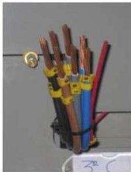
Figura 8.18. Conductores para la conexión de un contador.
