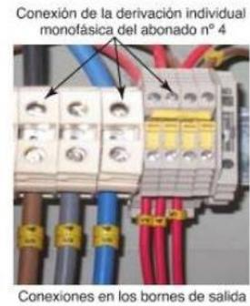
Conexiones en los bornes de salida
