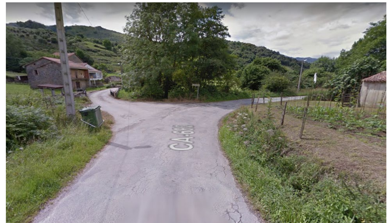
Figura 6. Mal estado de pavimento. Mala señalización.
