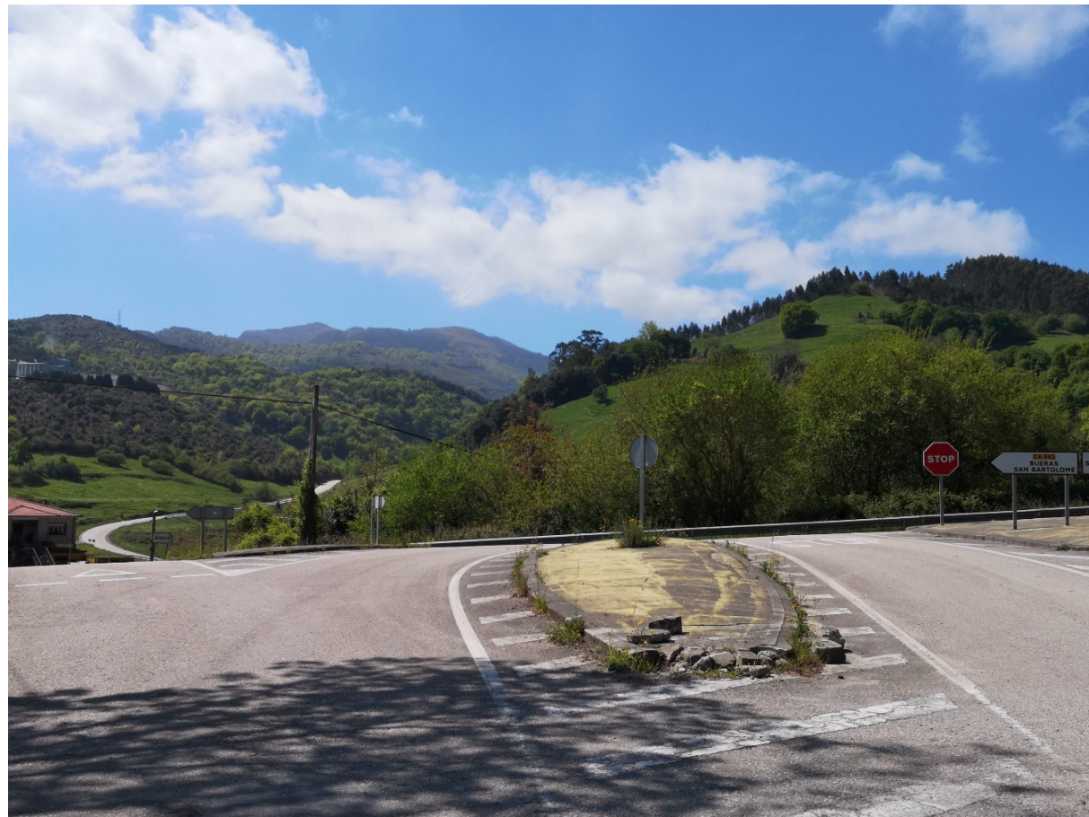
Figura 11. Intersección de CA-682 con CA-683 de mala visibilidad.
