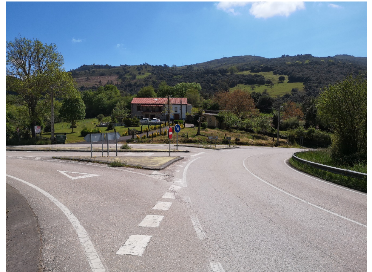
Figura 14. Intersección de CA-682 con CA-683 de mala visibilidad.
