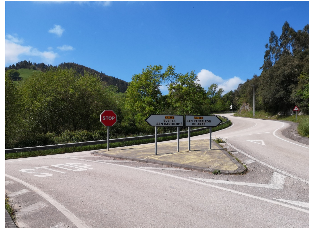
Figura 12. Intersección de CA-682 con CA-683 de mala visibilidad.
