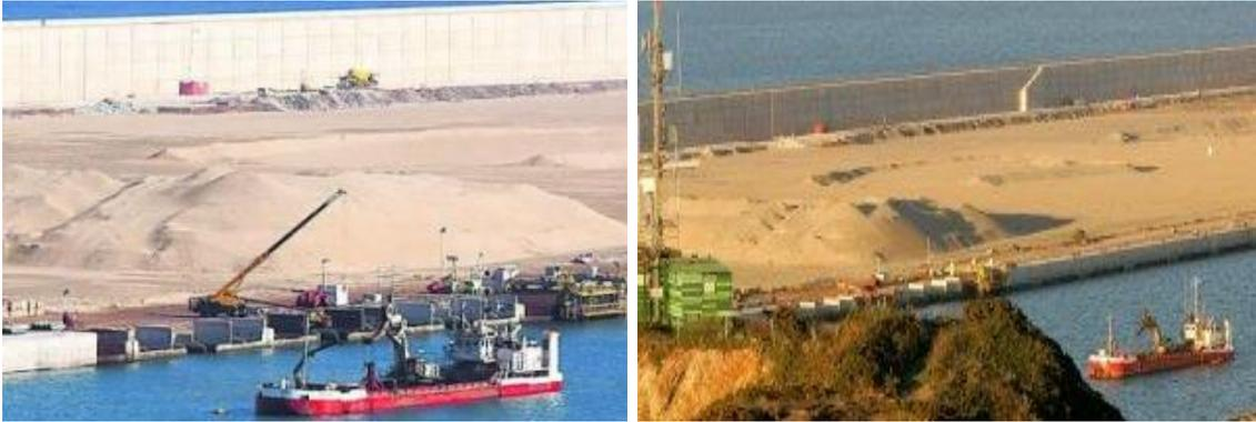
*Ilustración 7 - Imágenes de los acopios en el puerto de Gijón del material dragado en 2010*
