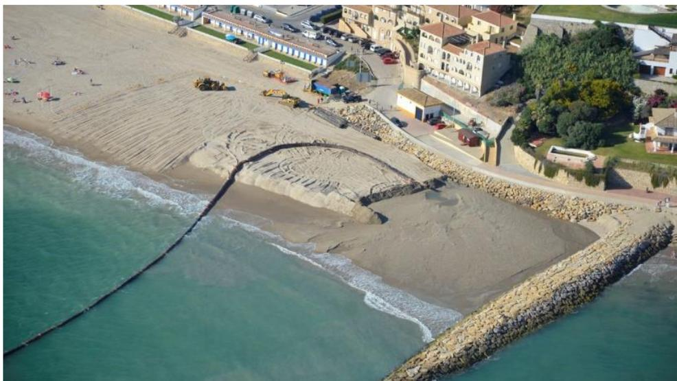
*Ilustración 17 - Tubería vertiendo agua y arena en una playa de Cádiz en 2015*
