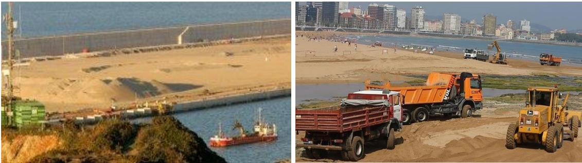
*Ilustración 2 - Acopio de material dragado en 2010 que resultó tener un tamaño mayor del esperado (izquierda) y trabajos de trasvase de arena en 2014 (derecha)*
