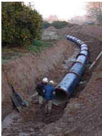
*Figura 39: Tubería de hierro fundido dúctil con bloqueo articulado.*
