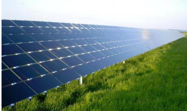
*Ilustración 11: Paneles solares de capa fina (Fuente: <http://www.energiasrenovablesinfo.com>)*
