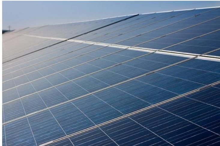
*Ilustración 10: Paneles solares policristalinos (Fuente: <http://www.energiasrenovablesinfo.com>)*
