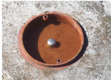
Figura Número A.2.13.- Señalización empleada para la auscultación altimétrica.
