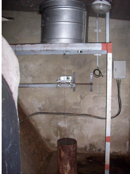
Figura Número A.2.6.- Mecanismo del péndulo invertido
