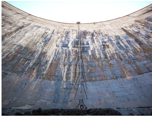
Figura Número IV.11.- Bajante del péndulo sobre el paramento de la presa.
