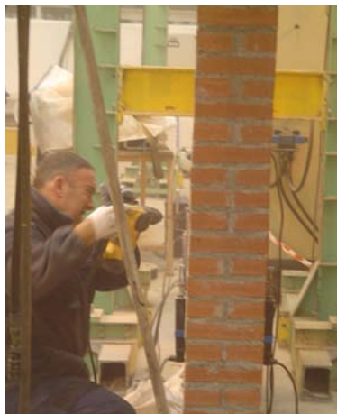
Apertura de roza mediante taladro
