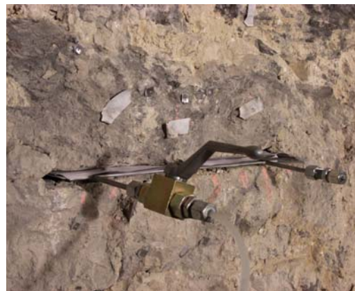
Detalle del área de ensayo
