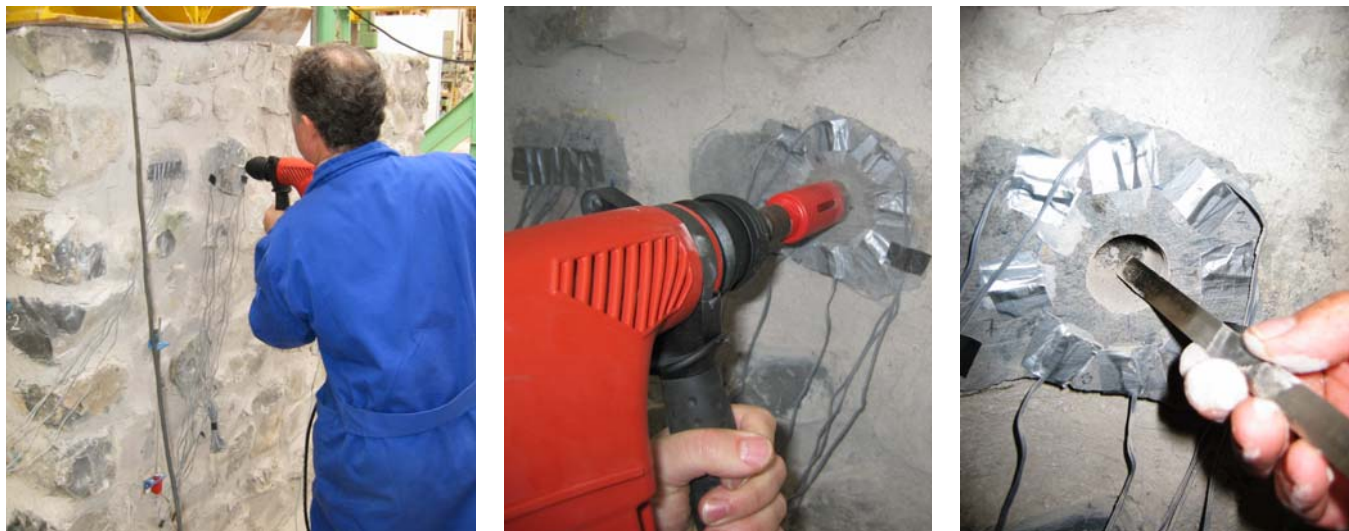
Fotografías del proceso de ejecución.
