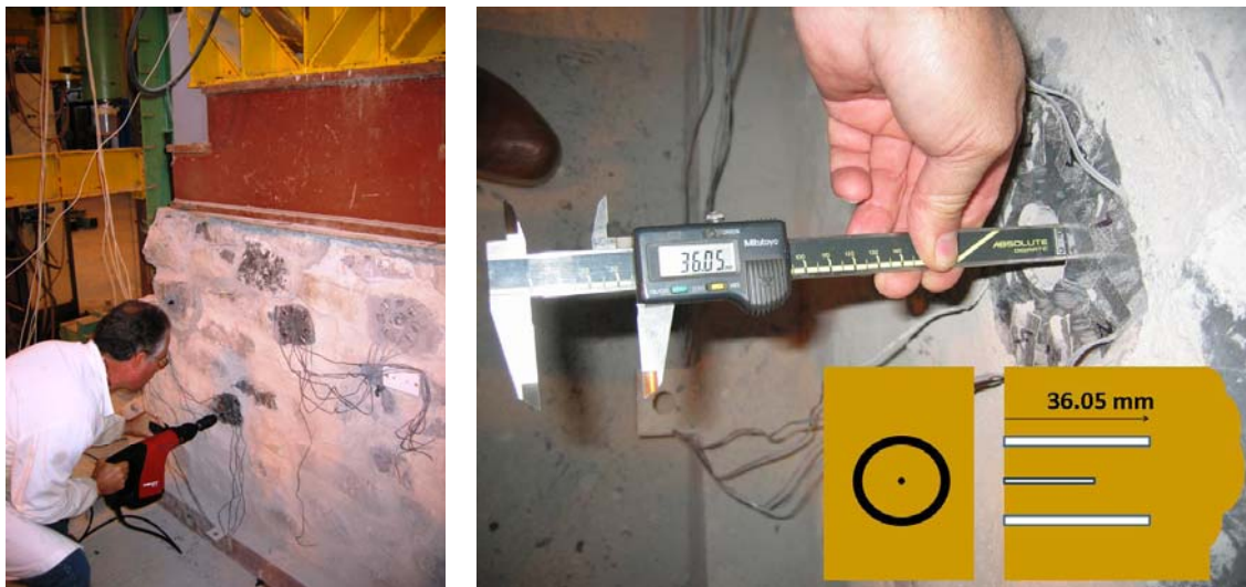
Fotografías del proceso de ejecución.
