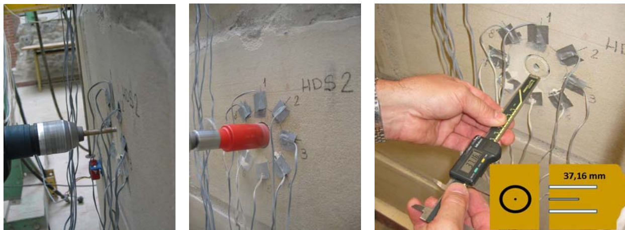
Fotografías del proceso de ejecución.
