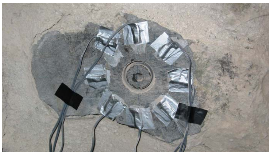
Emplazamiento del ensayo HDM2 una vez finalizado
