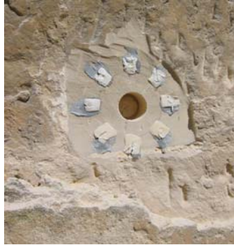
Detalle de la zona del ensayo una vez finalizado
