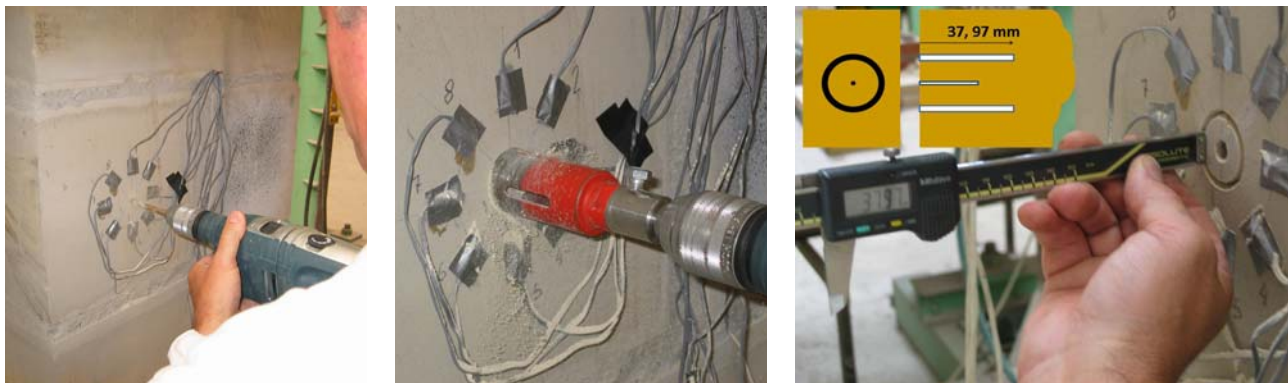
Fotografías del proceso de ejecución.
