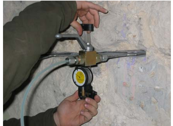
Detalle del área de ensayo
