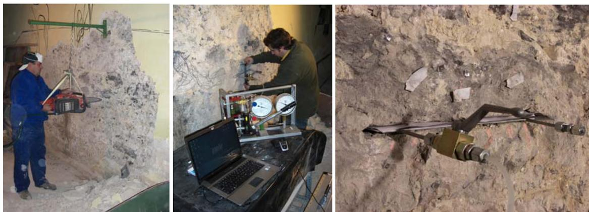
Fig. 5.6.52: Ejecución de la roza mediante sierra de disco orbital.
