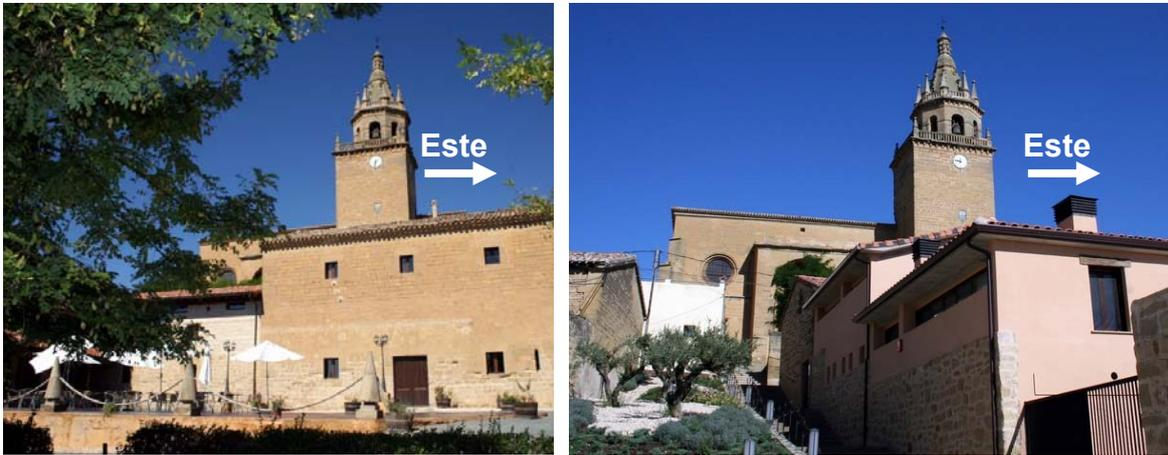
Fig. 5.1.39 y 5.1.40: Perspectivas de la iglesia de Nª Sª de la Asunción de Zarratón en la que puede apreciarse como el cimborrio de coronación del cuerpo prismático de la misma no está centrado en la dirección Oeste-Este.
