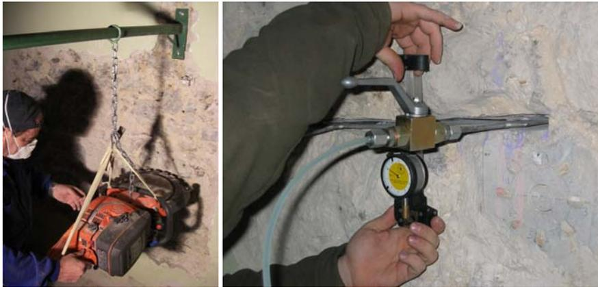
Fig. 5.6.59: Ejecución de la roza mediante sierra de disco orbital.
