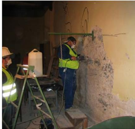
Fig. 5.6.111: Ejecución de la roza del gato plano superior mediante sierra de disco orbital.
