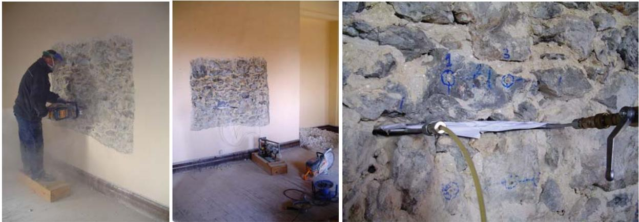
Fig. 5.6.45: Ejecución de la roza mediante sierra de disco orbital.
