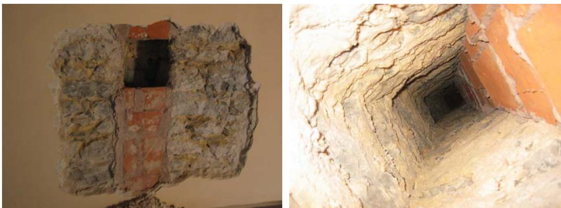
Fig. 5.6.143 y 5.6.144: Hueco vertical existente empotrado en la crujía Sur del muro central de mampostería, en el claustro Este.
