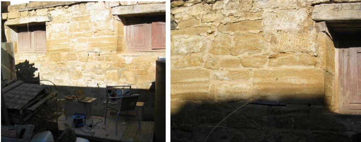
Fig. 5.2.20: Configuración general del ensayo. Puede apreciarse como el muro de fábrica ensayado finaliza en la parte superior de la fotografía, por ello que el nivel de carga existente en la zona de ensayo fuera muy reducido.
