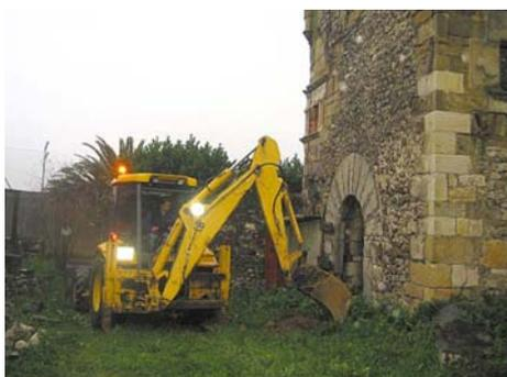
Fig. 5.3.15: Fotografía tomada durante la realización de una de las calicatas anexa al muro Este de la torre Sureste (cortesía Triax).
