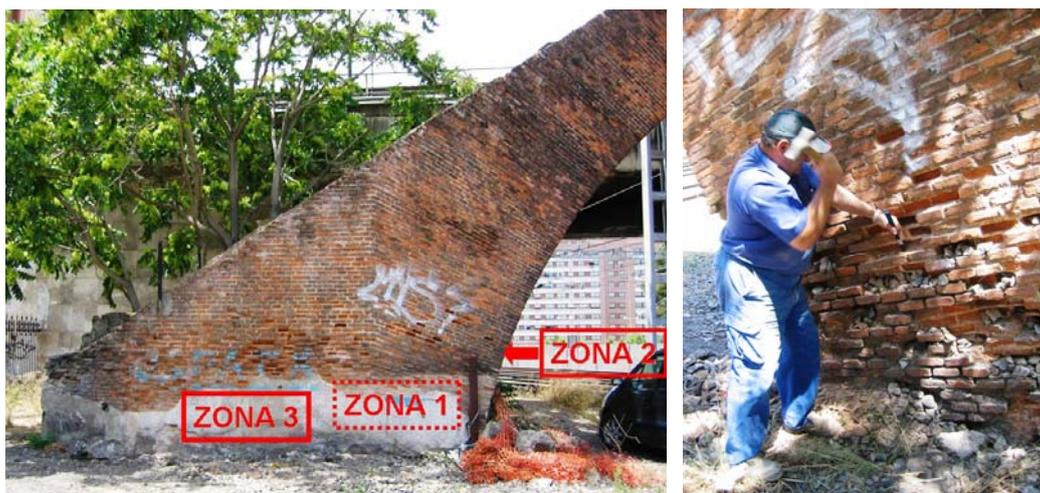
Fig. 5.5.8 y 5.5.9: Zonas de toma de muestras (la zona 1 corresponde con la cara opuesta a la mostrada en la fotografía) y detalle de un instante de las tareas de extracción.
