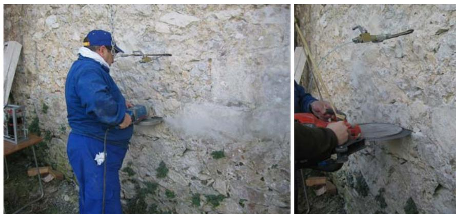
Fig. 5.3.53: Corte mediante sierra de disco manual para guiado en la fase de ejecución de la roza.
