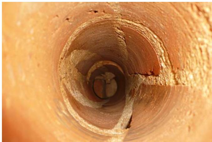
Fig. 5.5.43: Sondeo mecánico realizado en el arco para evaluar su sección transversal (Fuente: J.A. Martínez).
