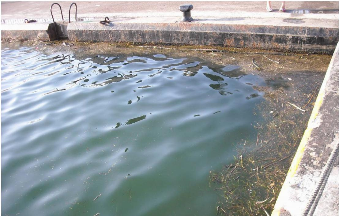
Fotografía 4: Dársena de los nuevos muelles del puerto autonómico de Colindres con hidrocarburo emulsionado y palillería en las aristas del muelle. Fuente: Autor.
