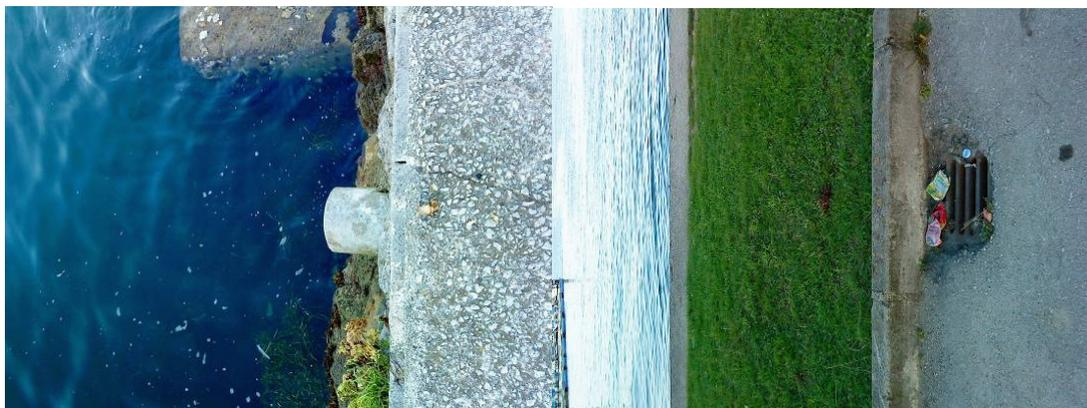
Fotografía 14: A la derecha, alcantarilla en la carretera de entrada; nótese la salida del colector (fotografía de la izquierda) directo al mar, en la zona de los atraques de las embarcaciones en Marina de Santander (Camargo). Fuente: Autor.
