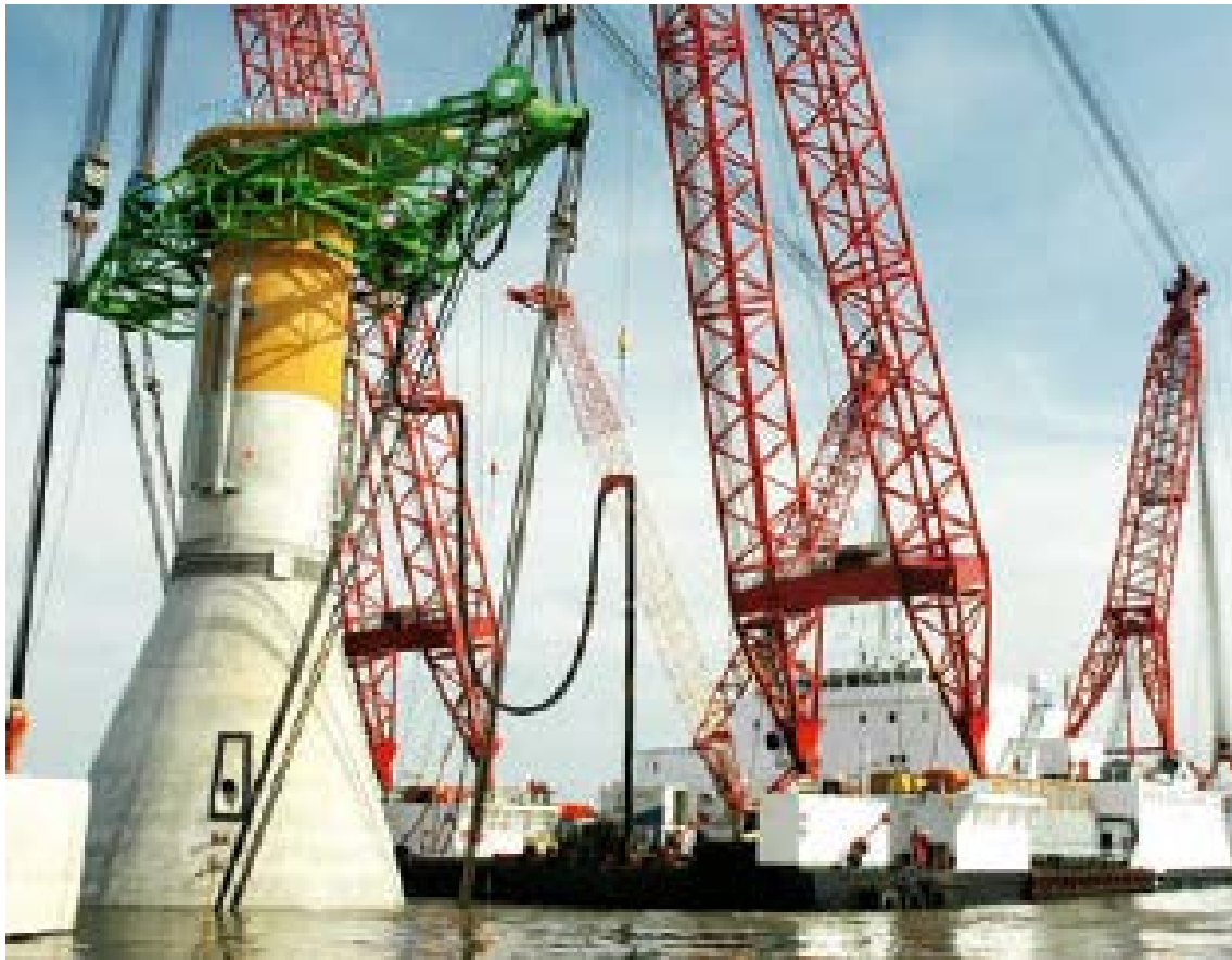
Figura 8: Grúa RAMBIZ fondeando una cimentación del parque Thornton Bank (Fuente: Ref. [6])
