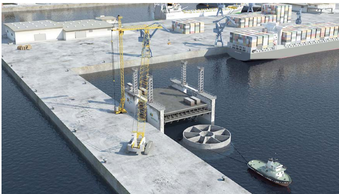
Figura 18: Ejemplo de construcción en cajonero y remolque de la base
