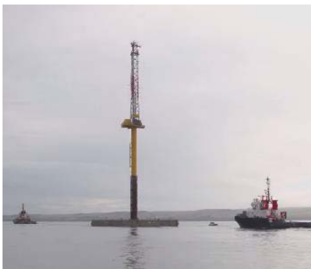
Figura 10: Estructura tipo cajón de DRACE (dcha.) y Seatower (dcha.) para cimentación de mástil meteorológico (Fuente: Ref. [8])
