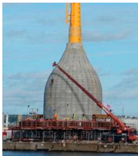
Figura 10: Estructura tipo cajón de DRACE (dcha.) y Seatower (dcha.) para cimentación de mástil meteorológico (Fuente: Ref. [8])
