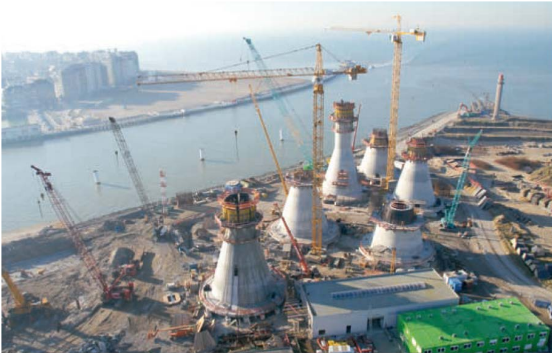
Figura 7: Construcción de las cimentaciones para el proyecto Thornton Bank en el puerto de Ostende (Fuente: Ref.: [6])
