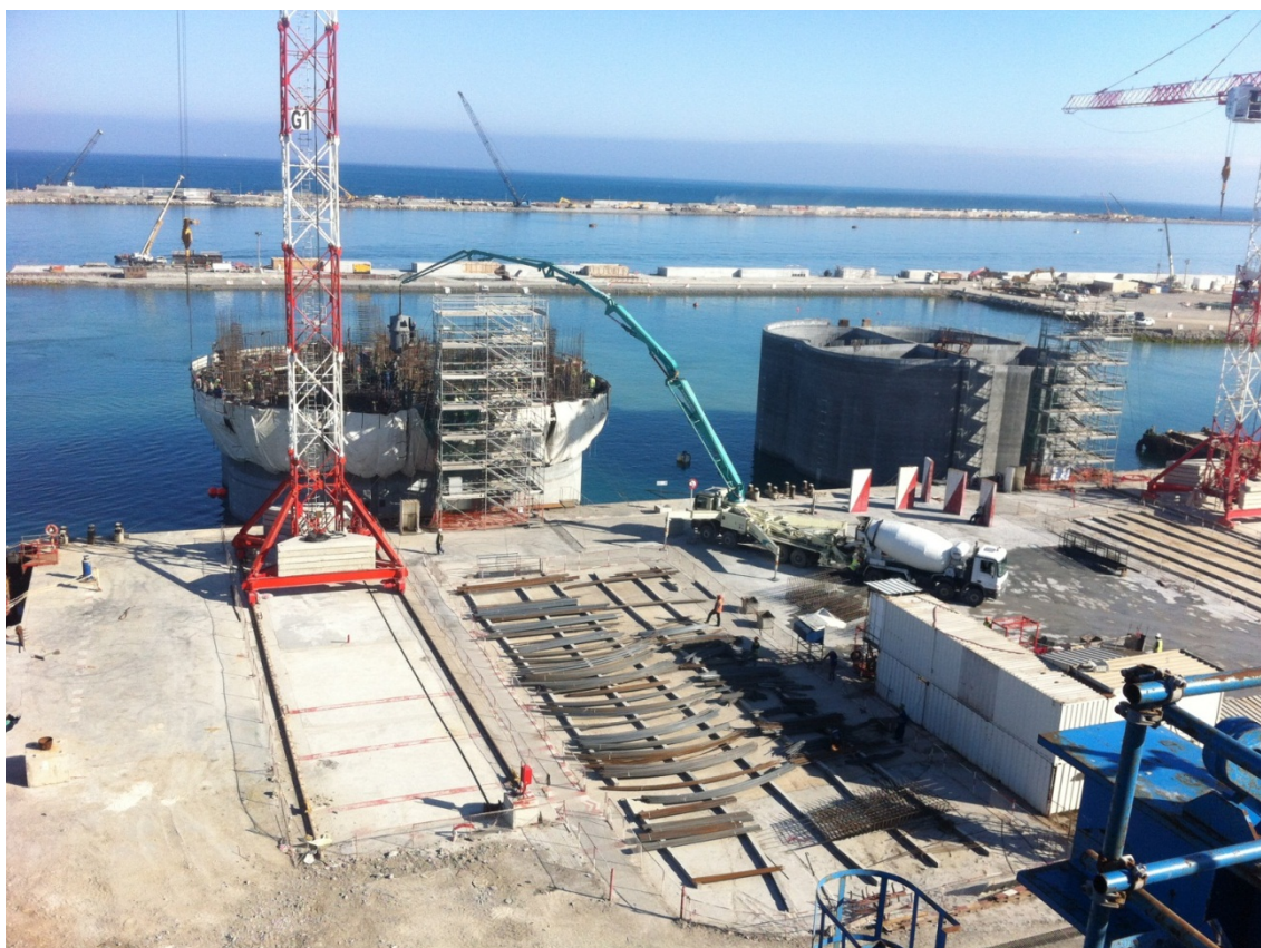
Figura 45: Continuación de construcción de cajón flotante una vez botado (Fuente: Bouygues Construction)
