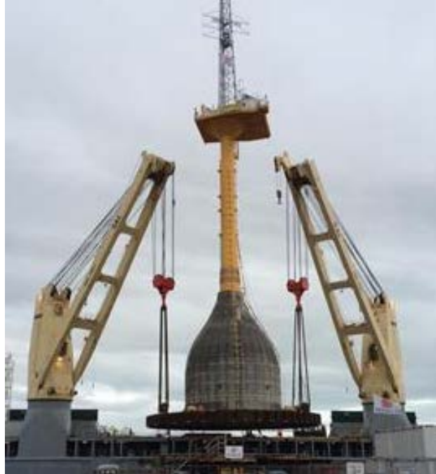
Figura 20: Prototipo de la solución Seatower con faldones o "skirts" que se insertan en el lecho marino (Fuente: windpoweroffshore.com )
