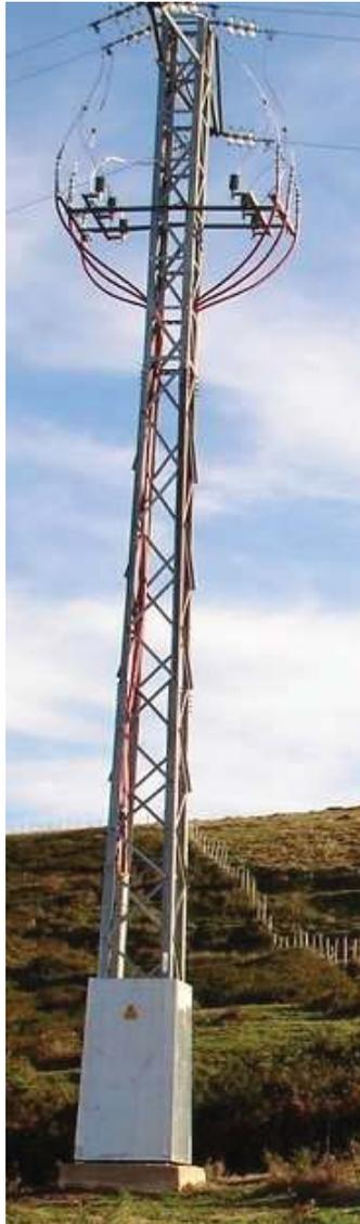
*Imagen 5.2.2.2 Antiescalo en apoyo con doble conversión.*
