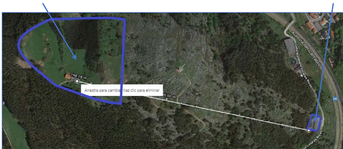
Ilustración 71: Distancia del terreno al centro de transformación. Fuente: Google maps
