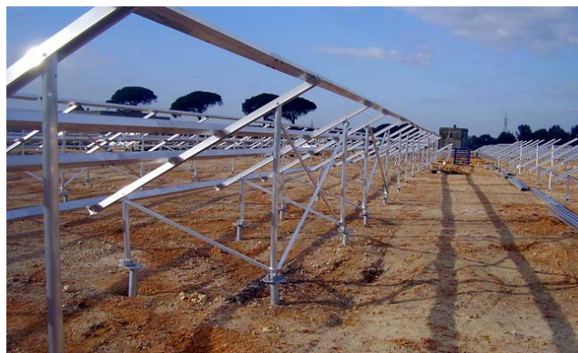
Ilustración 36: Estructura fija. Fuente: www.lealmetal.es
