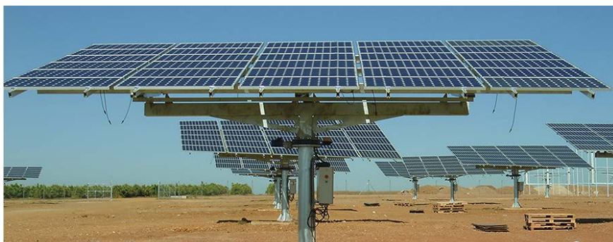
Ilustración 39: Soporte con seguimiento solar 2 ejes (Instalación Córdoba). Fuente: www.magtel.es
