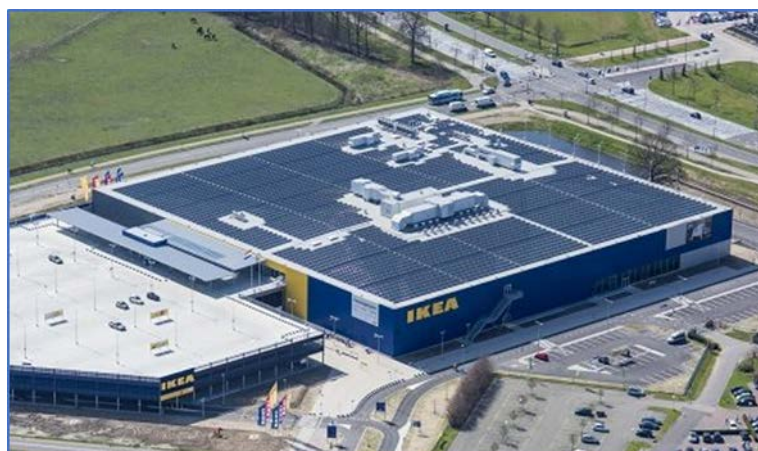
Ilustración 42: Instalación FV sobre nave. Fuente: www.diariorenovables.com
