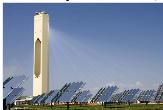
Ilustración 13: Central Termosolar PS10 (Sanlúcar la Mayor). Fuente: www.empresariosagrupados.es
