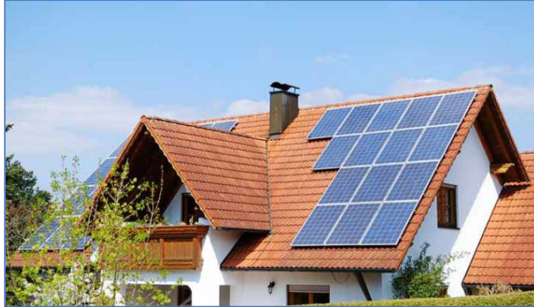
Ilustración 43: Instalación FV sobre vivienda. Fuente: www.cemaer.org
