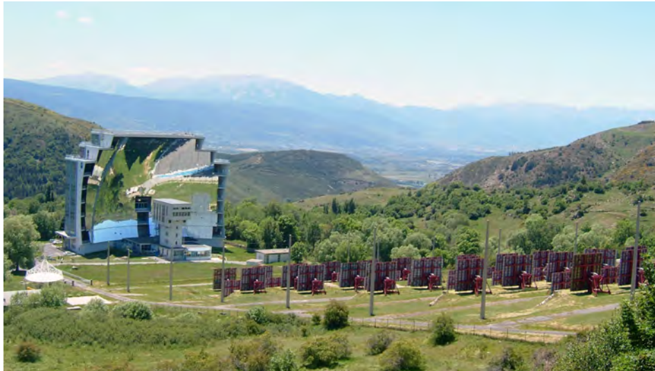
Figura 3.12. Captación de energía térmica de media temperatura mediante heliostatos
