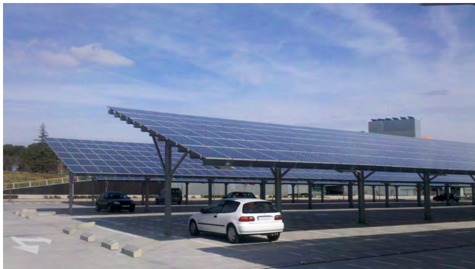
Figura 3.14. Parking comercial con tejavana cubierta de paneles fotovoltaicos
