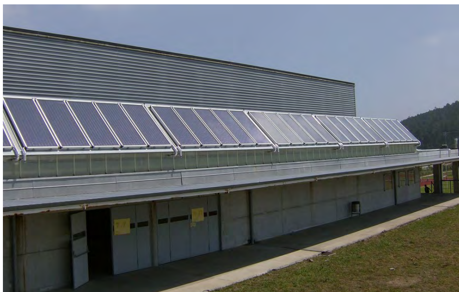
Figura 3.11. Captación de energía térmica de baja temperatura
