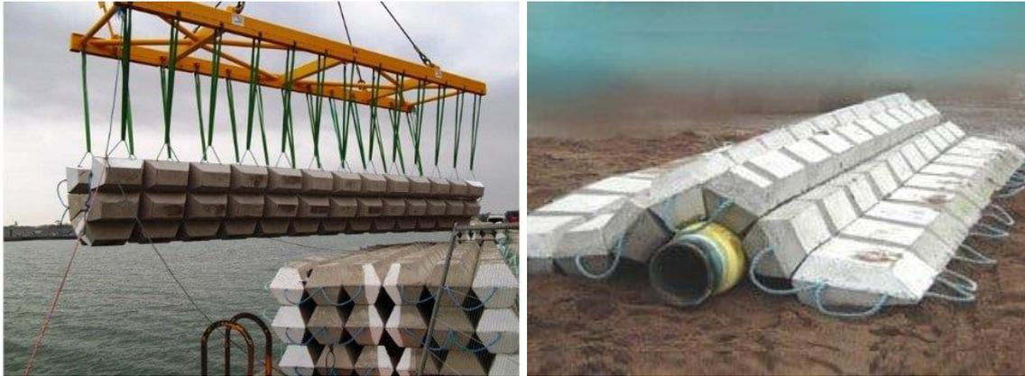
Figura 1.16 Disposición de hormigón con magnetita como protección de las conducciones submarinas.
