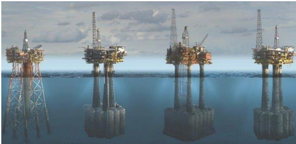
Figura 1.17 Hormigón de alta densidad empleado para la estabilización de las patas de la plataforma del Mar del Norte.
