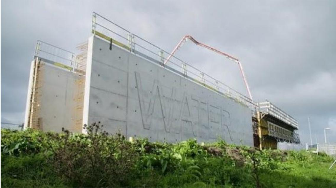
Figura 4.12 Cuenca con hormigón autorreparable en Rotterdam (Holanda).
