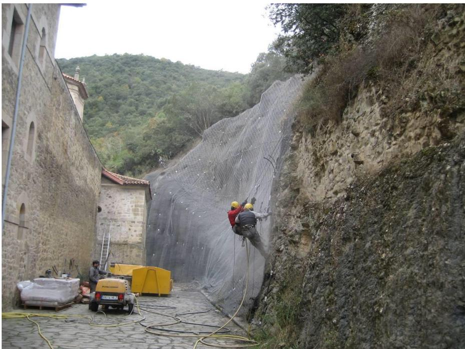
**FIGURA 26. TRABAJOS DE INSTALACIÓN DE LA MALLA DE SEGURIDAD PARA EL ARGAYO DE SANTO TORIBIO DE 2013 (IMAGEN: EL DIARIO MONTAÑÉS).**
