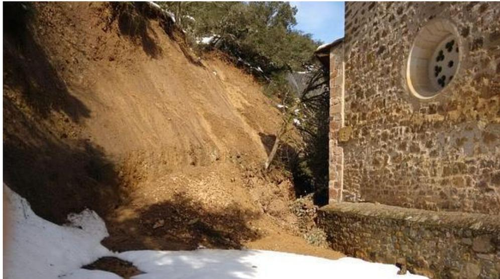
**FIGURA 27. IMAGEN QUE PRESENTABA EL DESLIZAMIENTO DE 2015 EN LA FACHADA TRASERA DEL MONASTERIO DE SANTO TORIBIO (IMAGEN: EL DIARIO MONTAÑÉS).**
