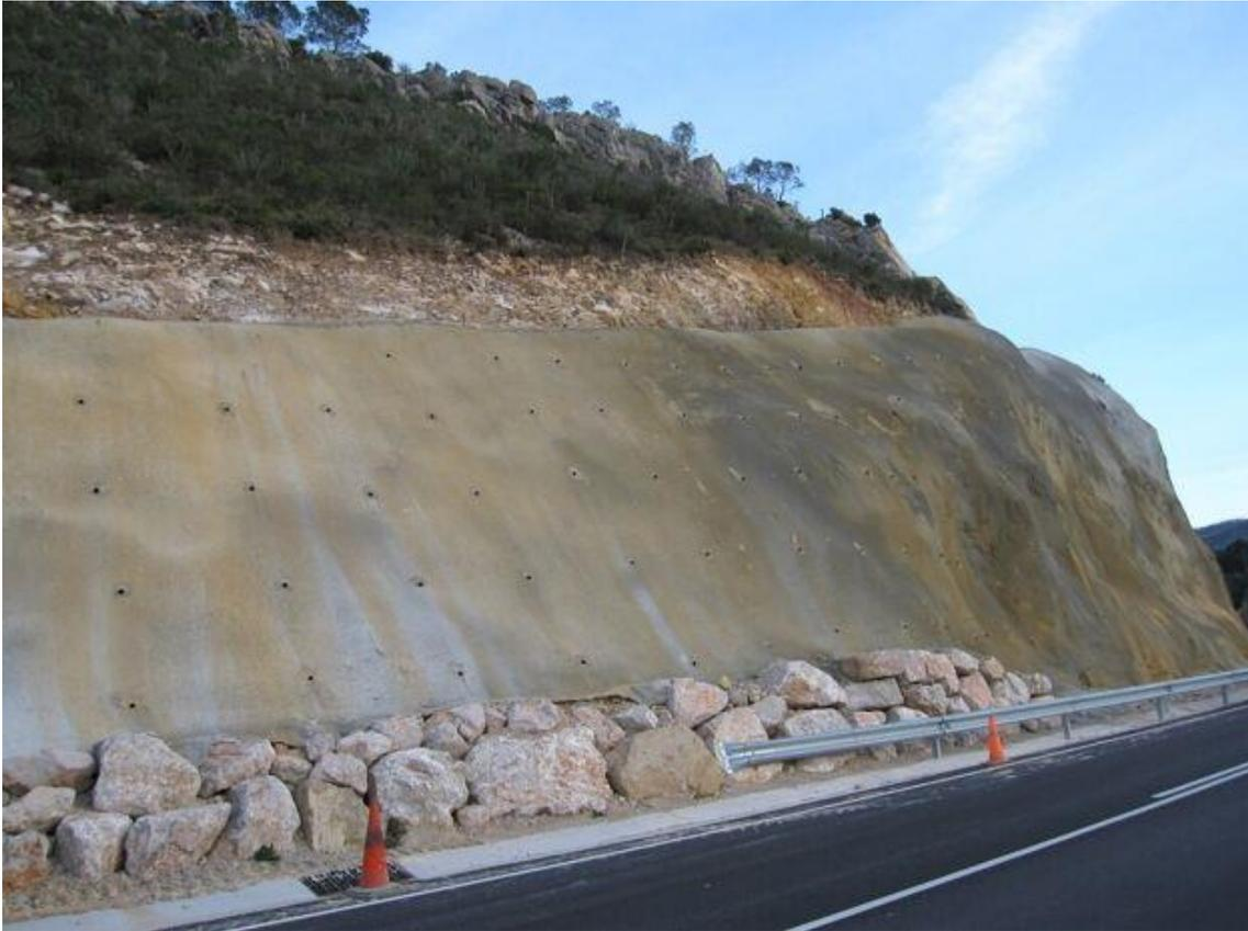
FIGURA 73. ESTABILIZACIÓN DE TALUD MEDIANTE GLUTINADO DE HORMIGÓN.
