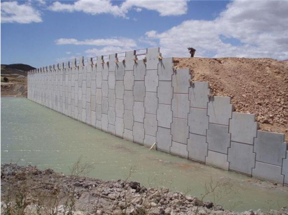
FIGURA 67. CONTENCIÓN DE TIERRA ARMADA.
