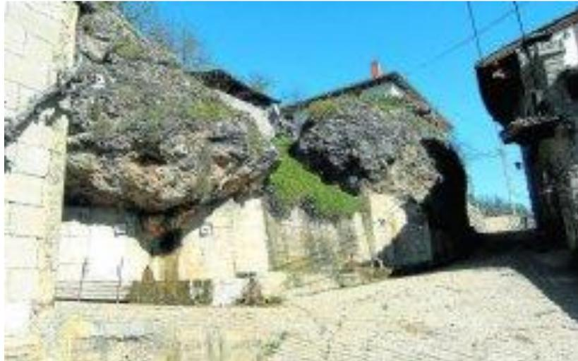
FIGURA 16. ROCAS ANCLADAS MEDIANTE TIRANTES EN 1985.
