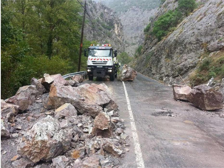
**FIGURA 32. LABORES DE RETIRADA DE LAS PIEDRAS DESPRENDIDAS SOBRE LA CARRETERA N-621, EN EL ARGAYO DEL 2014 SOBRE EL DESFILADERO DE LA HERMIDA (IMAGEN: EL DIARIO MONTAÑÉS).**
