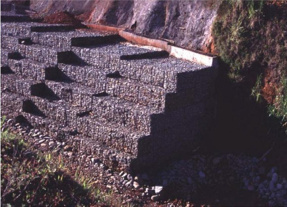
**FIGURA 66. CONTENCIÓN DE GAVIONES.**
