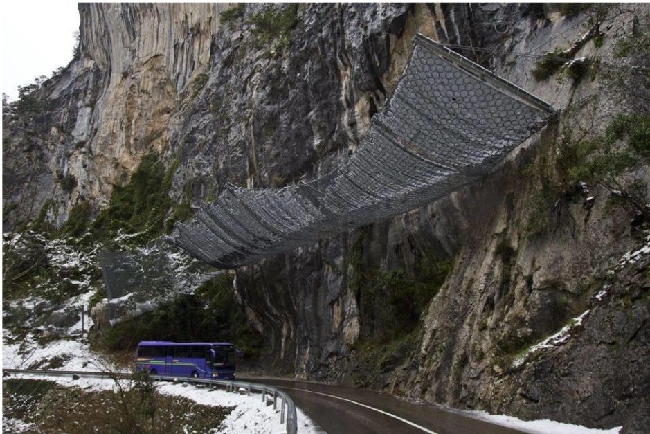
**FIGURA 33. IMAGEN QUE PRESENTAN LAS MALLAS PROTECTORAS DE EL DESFILADERO DE LA HERMIDA, LA CUAL DESCRIBE POR SÍ SOLA EL GRADO DE AMENAZA AL QUE SE ENCUENTRA SOMETIDA LA CIRCULACIÓN POR LA N-621 (IMAGEN: EL DIARIO MONTAÑÉS).**
