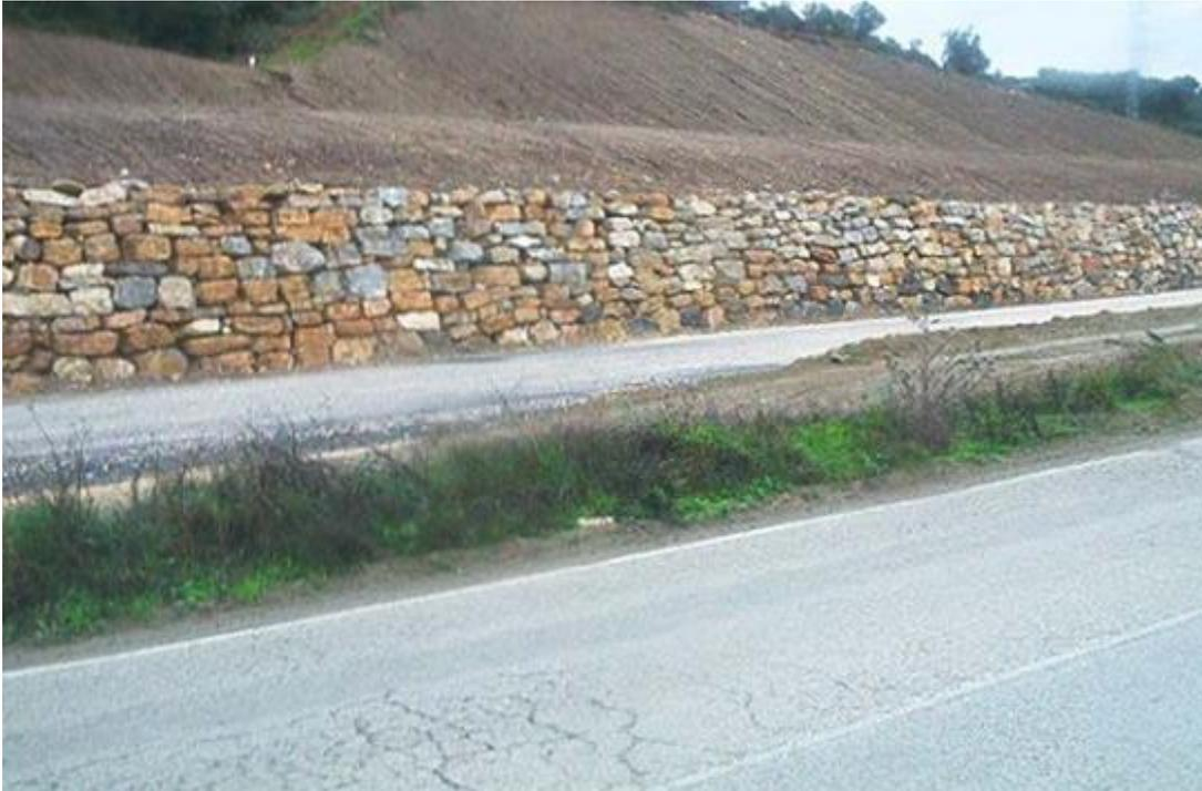
**FIGURA 65. MURO DE ESCOLLERA Y RELLENO DE TRASDÓS EN DESMONTE.**
