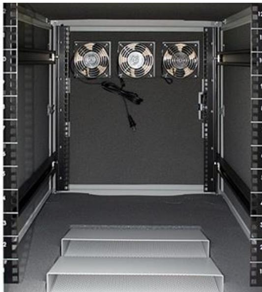
Figura 38: Ventilación de bastidores
