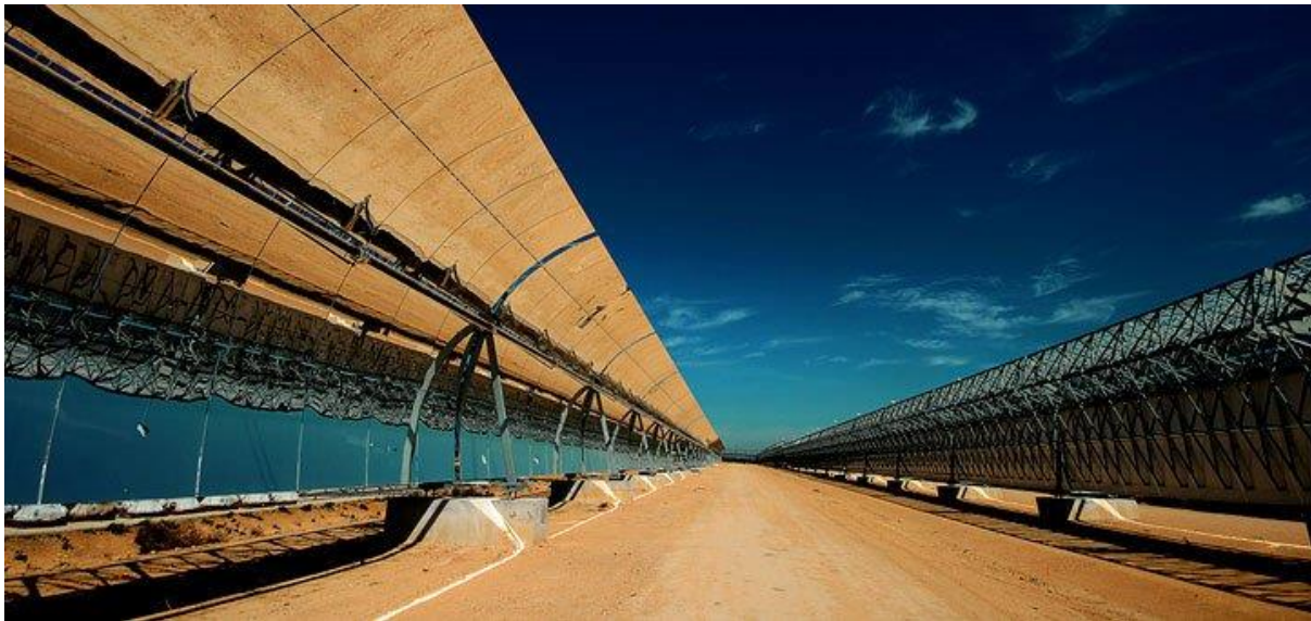
Ilustración 3-5 Plataforma Solar de Extremadura, España. Solaben. 200 MW.
