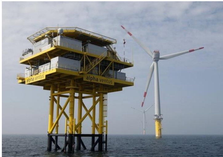
Ilustración 26. Subestación eléctrica offshore. Fuente: REVE
