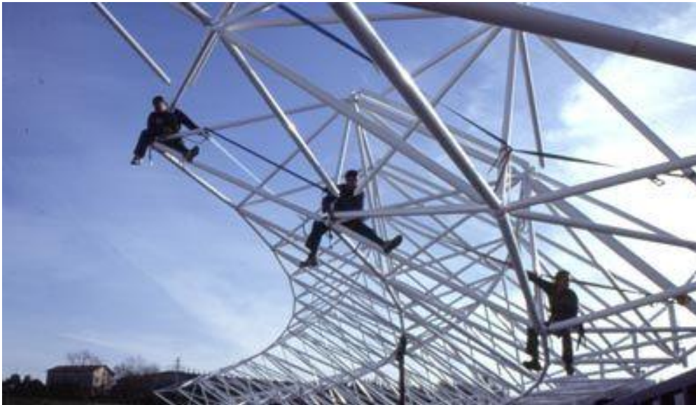
Figura 5. Montaje de estructura espacial. Imagen: http://www.arqhys.com
