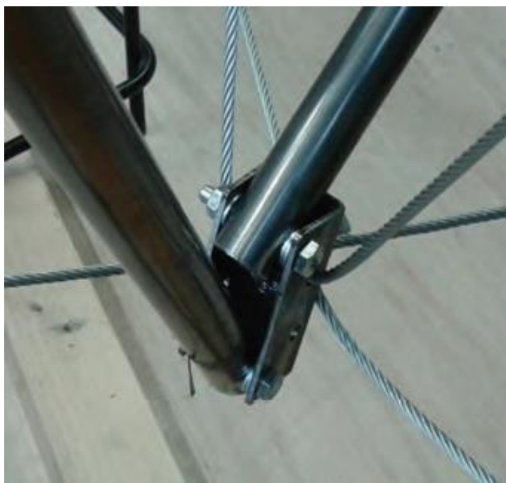
Figura 3. Nudo original con cargas desequilibradas
