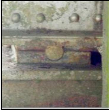
*Figura 5 Corrosión y deterioro de apoyo balancín de acero*
