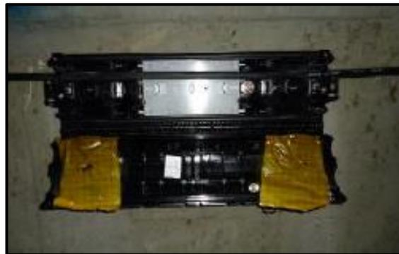
*Figura 17 Detalle de un anclaje de fibra óptica y caja de conexiones en tablero (Cortesía de Ineco; extraído de [T.4])*
