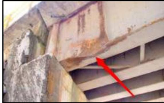
*Figura 6 Reducción de la sección de viga por corrosión e impacto*
