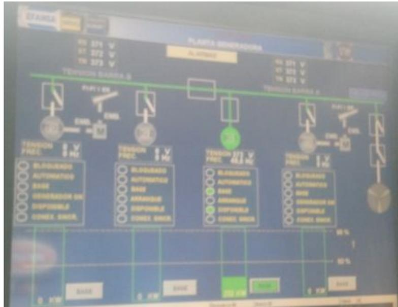
Detalle de la pantalla del software responsable de la gestión de energía a bordo del Luz de Mar. Véase el bus-tie cerrado y un generador arrancado operando por debajo del 50% de carga.
