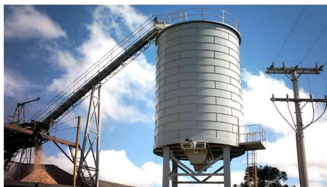
*Fig. 24. Silo de almacenamiento con cinta transportadora y descarga por gravedad.*
