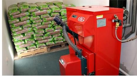
*Fig. 6. Caldera doméstica de pellet, en la que se muestra la necesidad de apilar el combustible. Fuente (ecologismos.com)*
