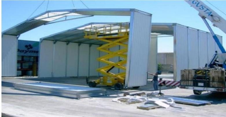
*Fig. 23. Proceso de construcción de una nave industrial prefabricada por la unión modular.
