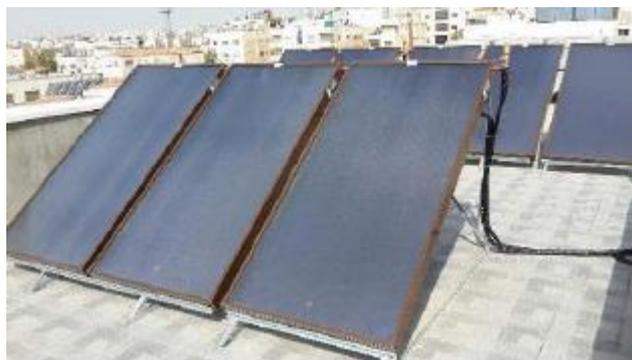
Figura 18. Colector solar Escosol FMAX 2.8.
