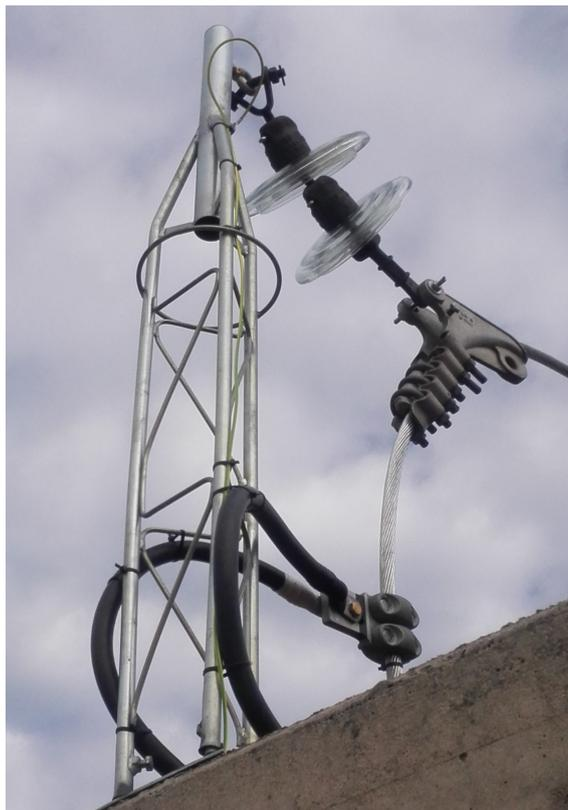
FIGURA 3.20: Composición de los apoyos y sujeciones del prototipo
