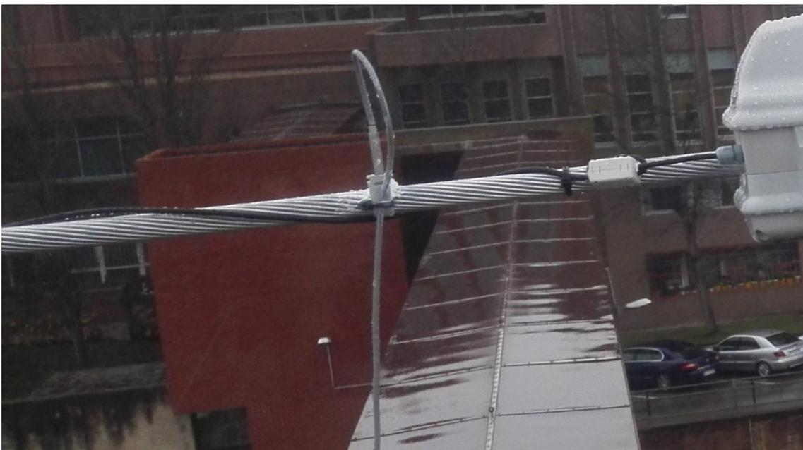
FIGURA 4.1: Fijación del sensor de contacto sobre el conductor
