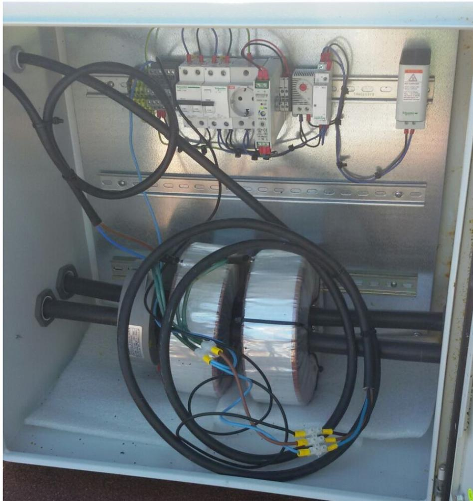
FIGURA 3.18: Acoplamiento de trafos toroidales para generar altas intensidades
