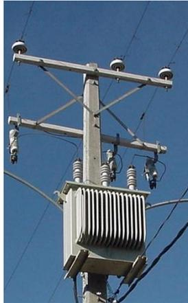
**Figura 4: Transformador de distribución [14].**
